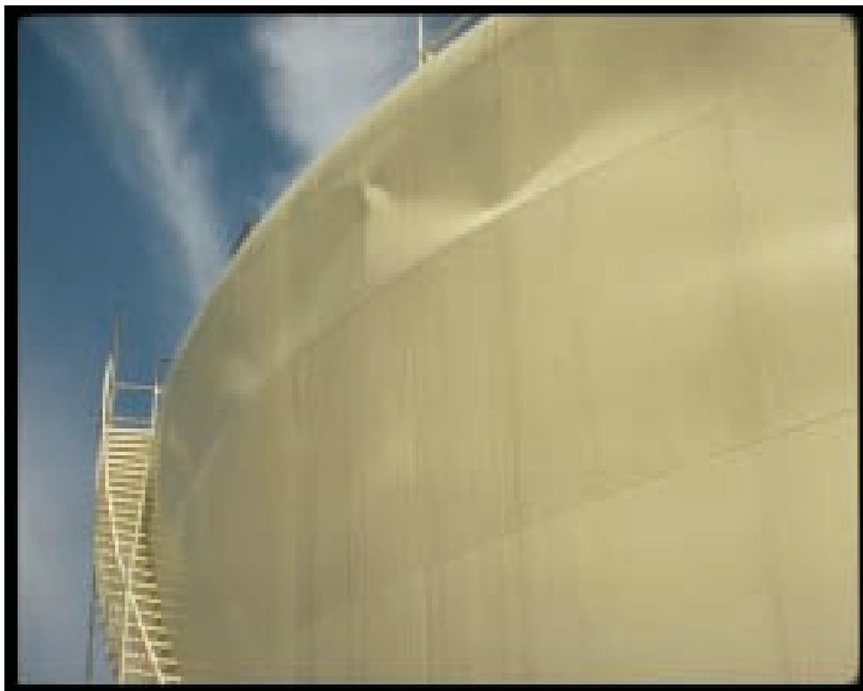
Figura 3.7 Falla de la parte superior de la pared por “sloshing”
