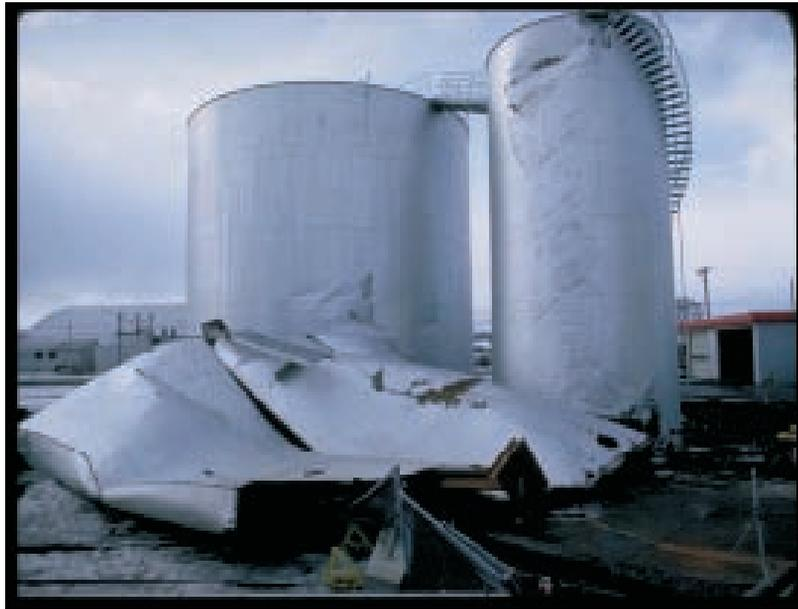
Figura 3.8 Colapso de un tanque de acero
