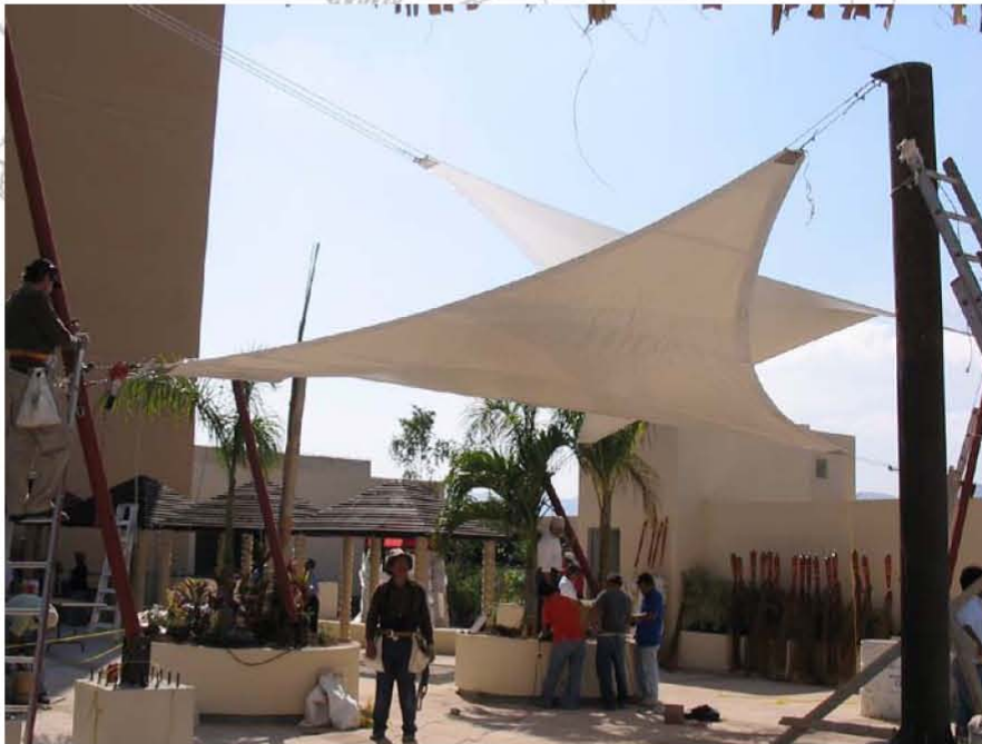
Ajustes durante el proceso de montaje. Supervisión de obra.
