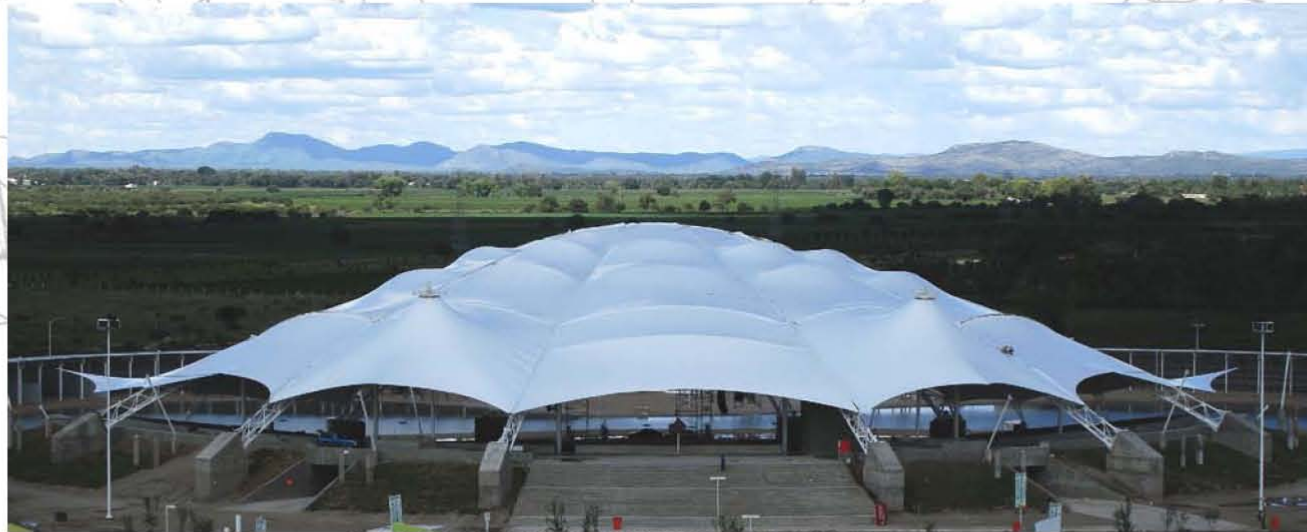
Vista panorámica desde la torre de acceso, expo-feria Durango, México.
