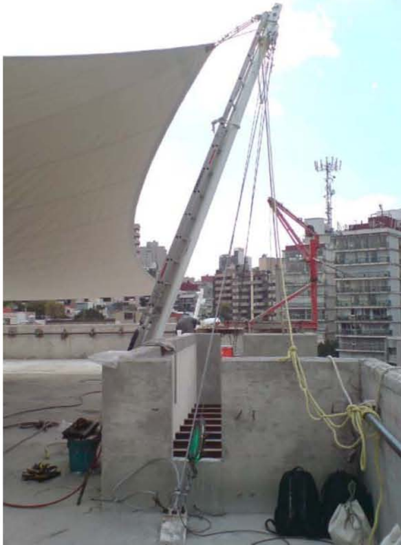
Vista parcial durante el montaje de la pieza.
