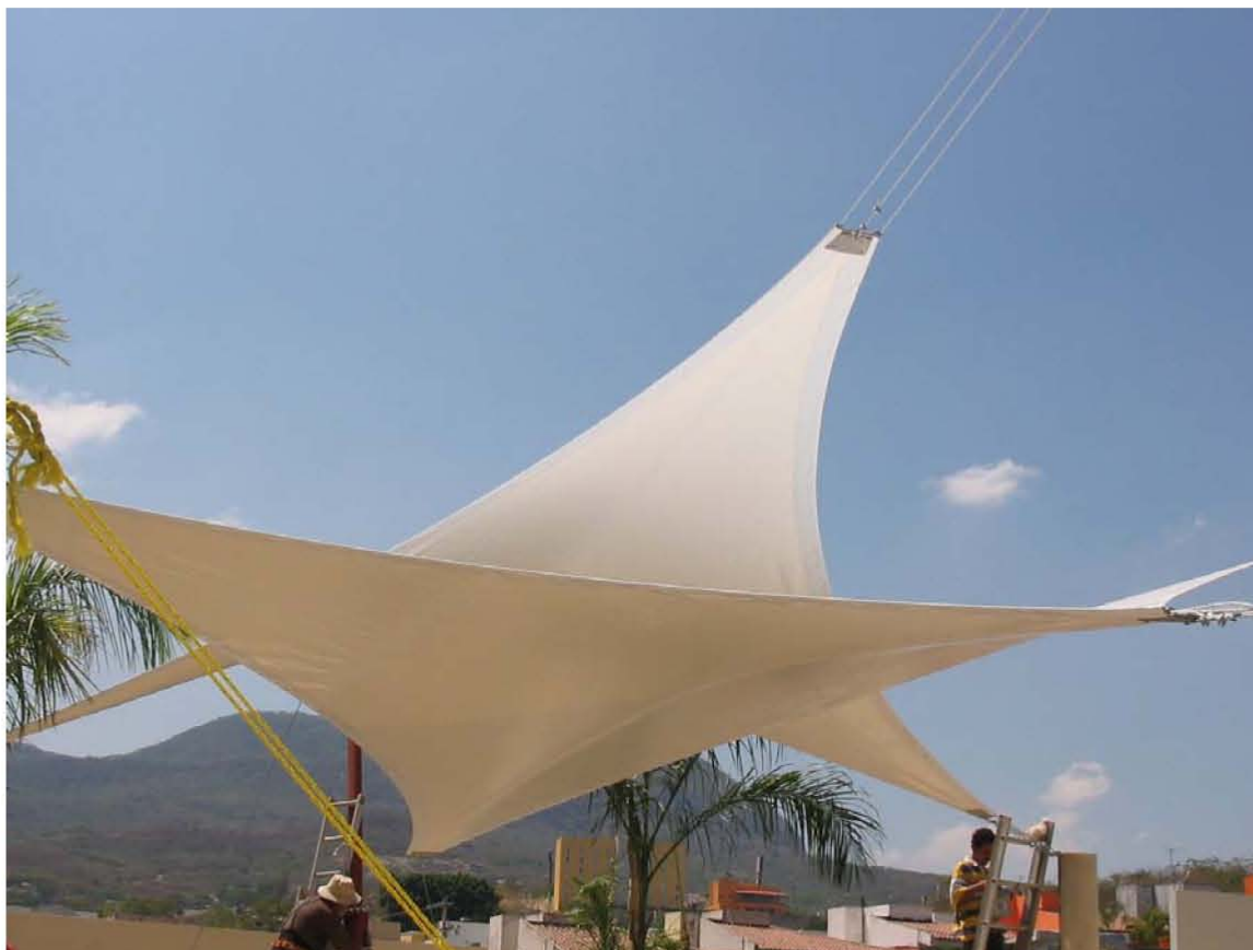
Vista inferior completa durante la finalización del montaje. Proyecto alberca-hotel, Tuxtla Gutierrez.
