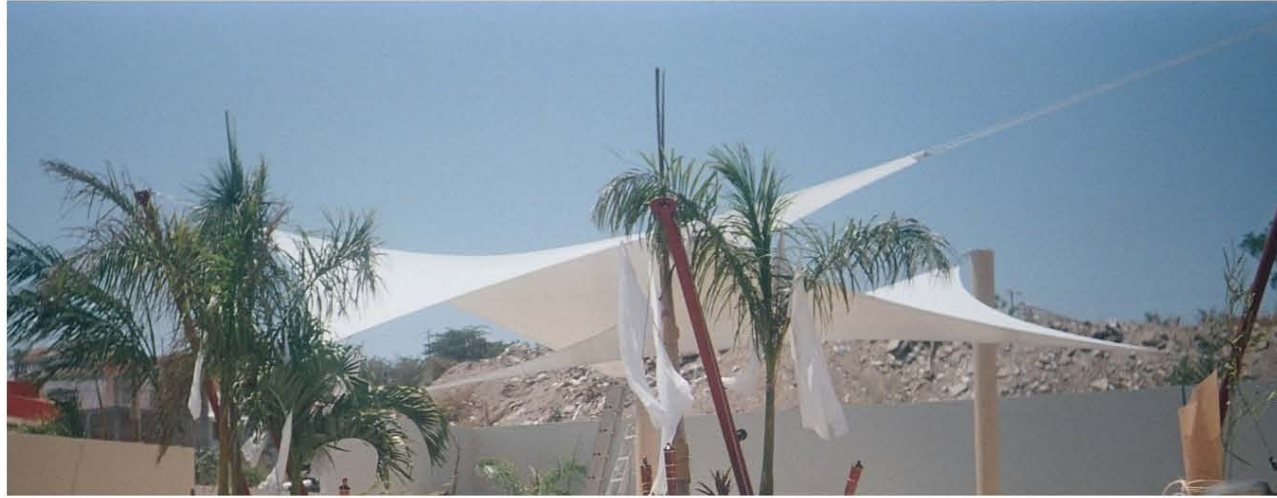
Vista final de la obra. Proyecto alberca-hotel, Tuxtla Gutierrez.
