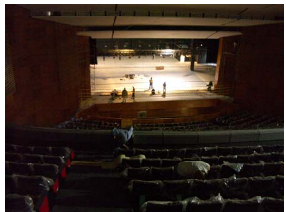
Vista del escenario del Teatro Auditorio La Gota de Plata, nótese que los muros laterales no son paralelos.
