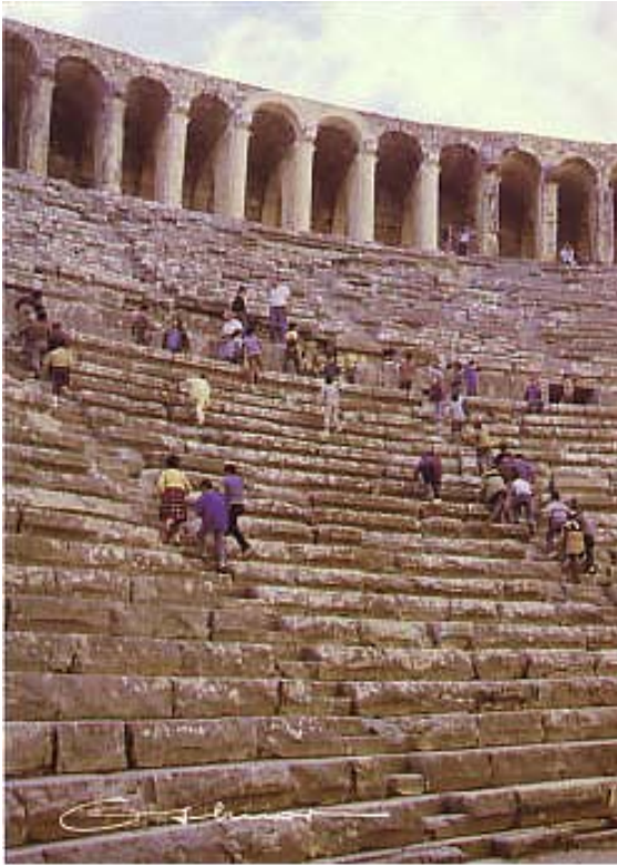
Teatro de Aspendus, capacidad de 6,000 espectadores. Los teatros romanos tenían una pendiente entre 30° y 34°
