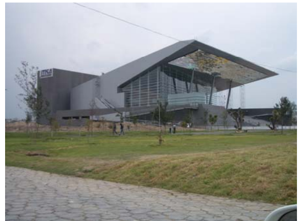
Vista lateral, se aprecia el volado
