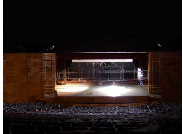
Vista interior, escenario, muros laterales y sala platea
