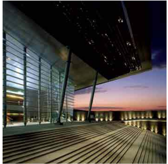
Vista de la fachada principal que es totalmente transparente, nótese los enormes cristales y esbeltos postes plateados. Al auditorio se accede a través de la escalinata.
