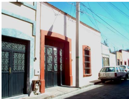
6.5.1.1 Fachada vivienda. Barrio de la Cruz. Año 2005
