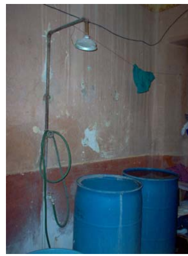
6.5.1.36 Regadera de una vivienda. Barrio de la Cruz Año 2005.
