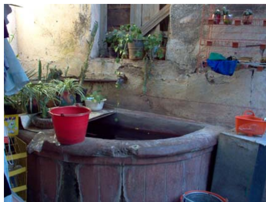
6.5.1.28 Lavaderos y pilas de una vivienda. Barrio de la Cruz. Año 2005.
