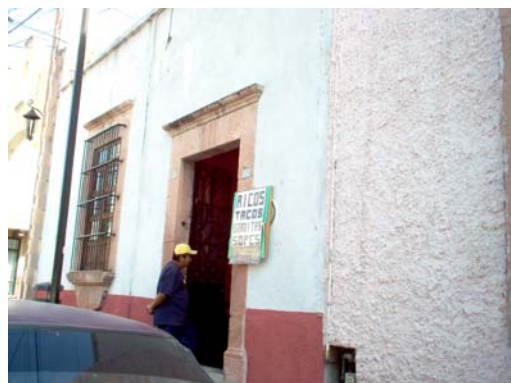
6.5.1.3 Fachada vivienda catalogada por el INAH. Barrio de la Cruz. Año 2005
