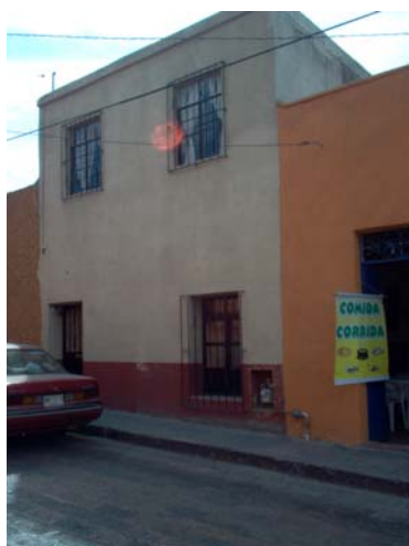
6.5.1.5 Fachada vivienda de dos niveles. Barrio la Cruz. Año 2005.
