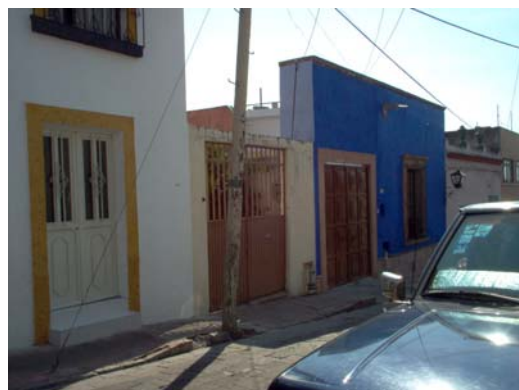
6.5.1.4 Fachada vivienda. Se muestra solo se conservo el muro de la fachada, al interior la construcción es actual. Barrio de la Cruz. Año 2005
