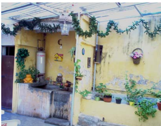
6.5.1.27 Lavaderos y pilas de una vivienda. Barrio de la Cruz. Año 2005.
