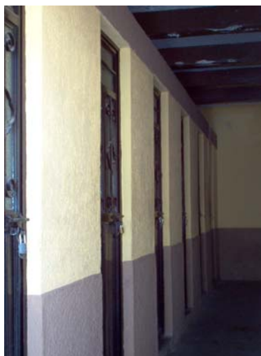
6.5.1.35 Sanitarios de una vecindad. Barrio de la Cruz Año 2005.
