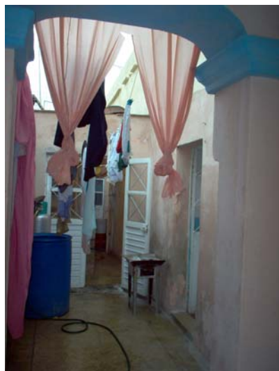
6.5.1.17 Patio de una vivienda. Barrio de la Cruz. Año 2005.
