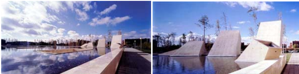
Figura 1, Figura 2 y Figura 3 en sentido del reloj: Tanatorio Municipal de León, 1997/2001. Arquitectos Jordi Badia y Josep Val / BAAS Arquitectes
