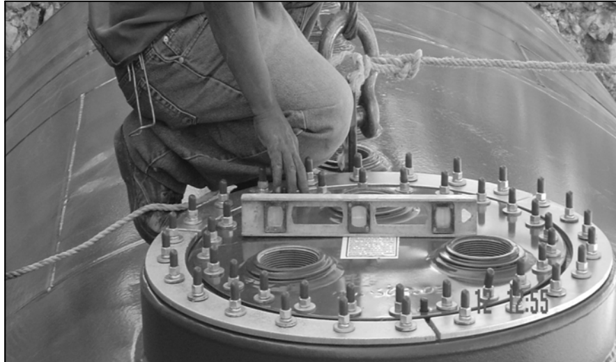
Figura 6.1.2 Nivelación de tanque
