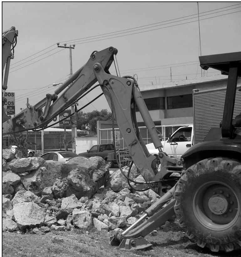
Figura 3.1.1 Demolición de estructuras existentes
