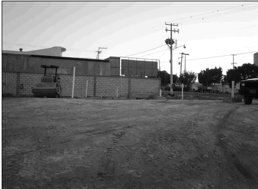
Figura 3.3.1 Trabajos de terracerías
