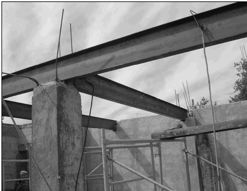
Figura 5.4.2 Colocación de vigas metálicas IPR de 10" de peralte
