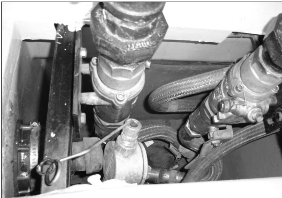
Figura 7.4.1 Conexiones eléctricas en dispensario
