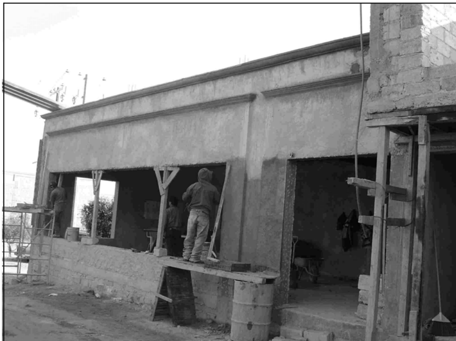
Figura 5.7.1 Detalle de aplanados en muros y plafones
