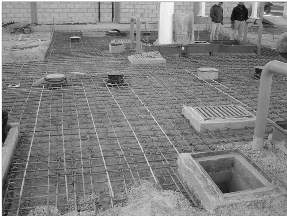
Figura 4.1.8 Detalle de armado de losa para piso
