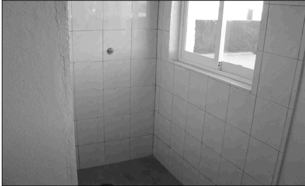
Figura 5.7.2 Detalle de lambrín de azulejo en baños
