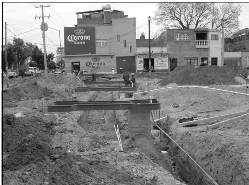
Figura 4.1.4 Detalle de cimbra metálica (hueso de perro)
