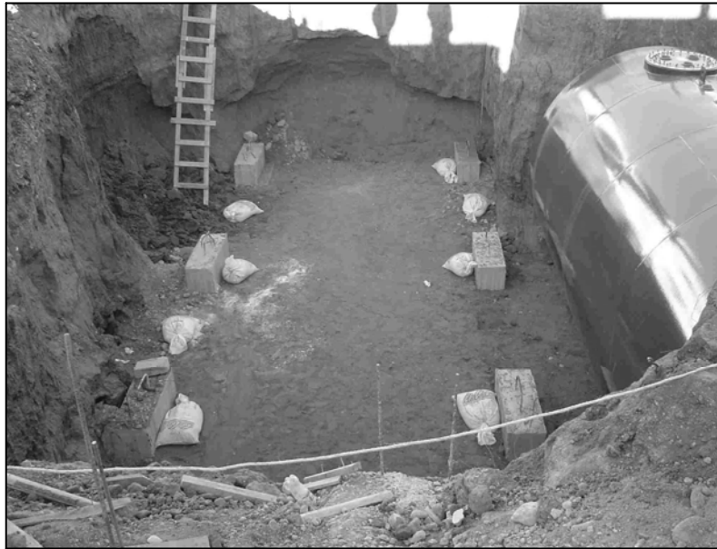
Figura 4.2.2 Detalle de plantilla y anclaje del tanque
