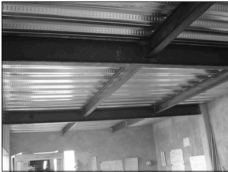
Figura 5.4.3 Colocación de losacero soldado a las vigas metálicas IPR de 10” de peralte
