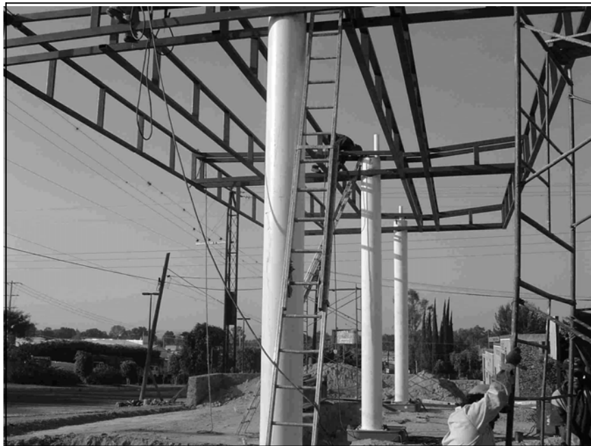
Figura 4.1.6 Detalle de estructura soporte de techumbre
