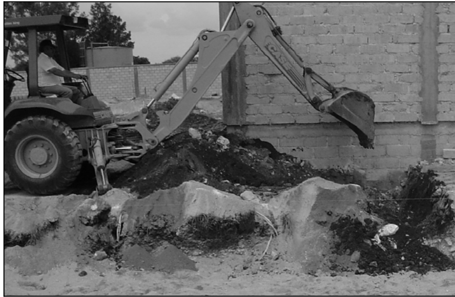
Figura 8.2.1 Excavación de cepas con máquina
