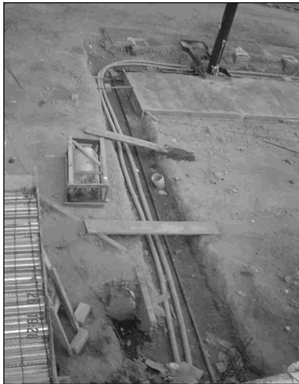
Figura 4.4.1 Trinchera para colocación de ductos
