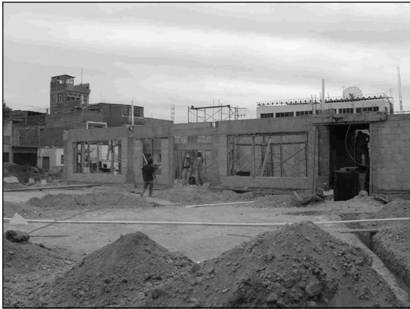
Figura 5.4.1 Construcción de muros de tabique
