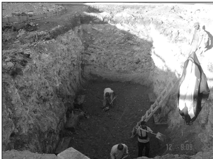
Figura 3.4.2 Excavación y afine de taludes y de plantilla de fondo
