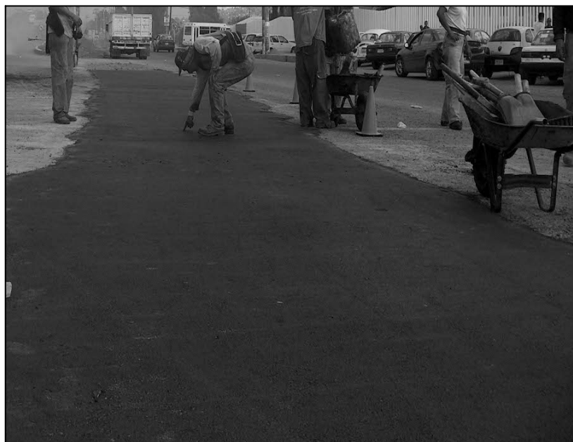
Figura 3.5.1 Colocación de concreto asfáltico
