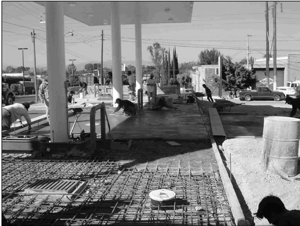
Figura 4.1.9 Detalle de armado y colado de losa de piso
