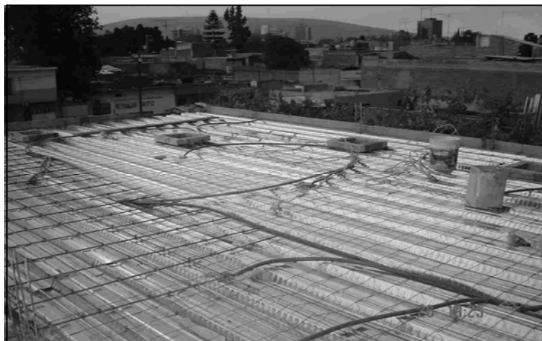
Figura 5.4.4 Colocación de malla electrosoldada 6-6, 10-10 y poliducto para instalaciones eléctricas
