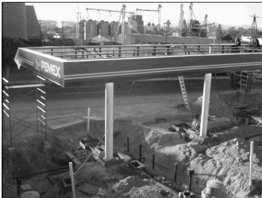
Figura 4.1.7 Detalle de colocación de faldón metálico institucional
