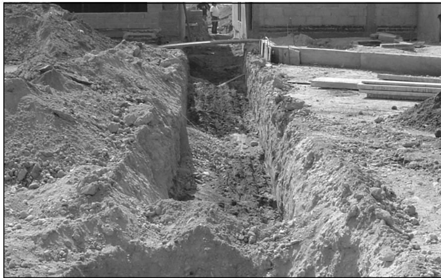
Figura 8.2.2 Excavación de cepas en terreno mejorado
