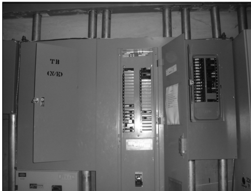
Figura 7.2.2 Tableros eléctricos
