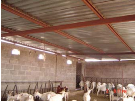
Foto 9. Techo de lámina galvanizada acanalada.
