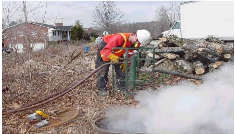
22.-Proceso de inyección de vapor a presión Fuente Industrias de Saneamiento y Desazolve, S.A. de C.V. Reproducción con fines académicos
