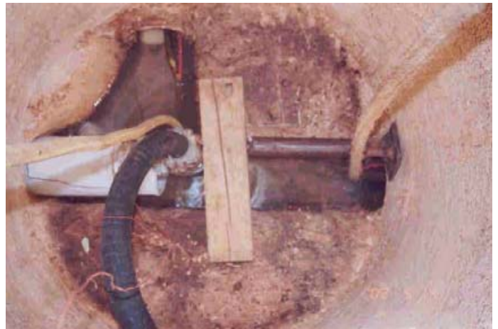
20.-Troqu沿海 provisional para resistir inyección de vapor a presión Fuente Industrias de Saneamiento y Desazolve, S.A. de C.V. Reproducción con fines académicos
