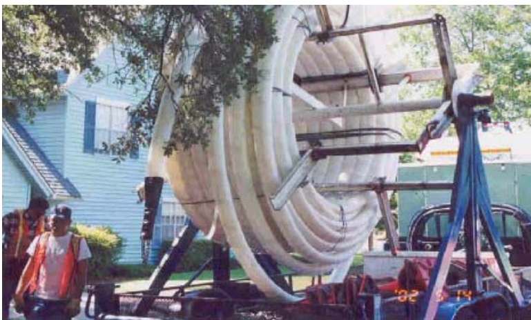
9.-Carrete de tubería de polietileno de alta densidad en forma de "U" Fuente Industrias de Saneamiento y Desazolve, S.A. de C.V. Reproducción con fines académicos
