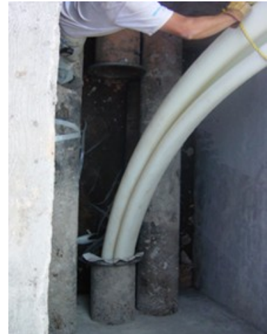
Introducción de tubería en U de polietileno de alta densidad
