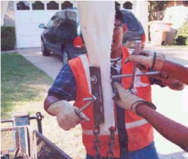
11.-Prperación de mecanismo para izado Fuente Industrias de Saneamiento y Desazolve, S.A. de C.V. Reproducción con fines académicos
