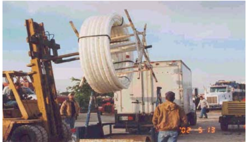
10.-Rollo de "U" Liner colocados en sitio Fuente Industrias de Saneamiento y Desazolve, S.A. de C.V. Reproducción con fines académicos
