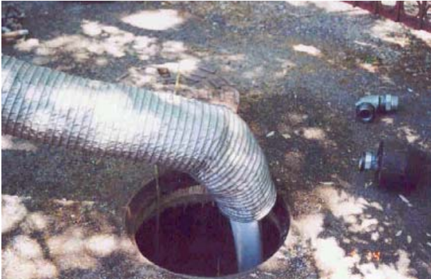
19.-Mecanismo para inyección de vapor a presión extremo inicial de la tubería Fuente Industrias de Saneamiento y Desazolve, S.A. de C.V. Reproducción con fines académicos
