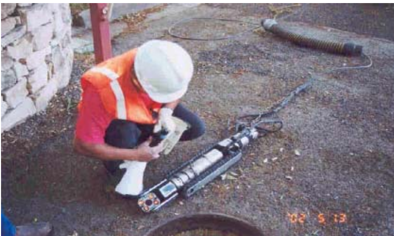
5.-Preparación de la cámara para monitoreo Fuente Industrias de Saneamiento y Desazolve, S.A. de C.V. Reproducción con fines académicos
