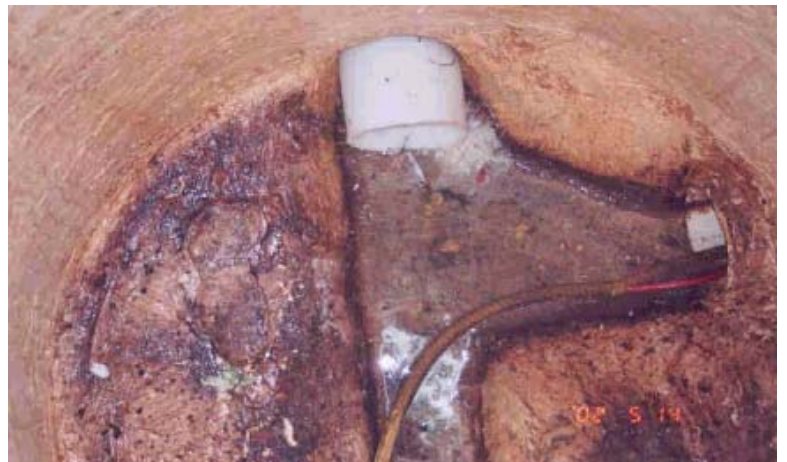
27.-Verificación de tubería colocada Fuente Industrias de Saneamiento y Desazolve, S.A. de C.V. Reproducción con fines académicos
