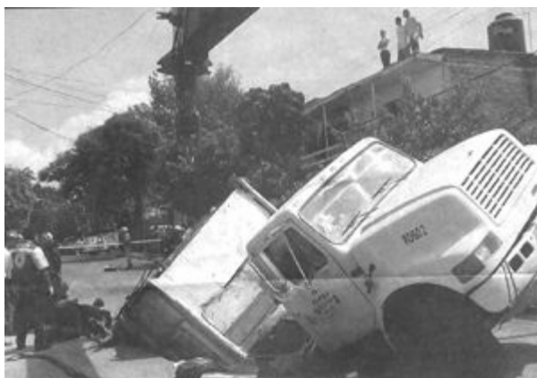
Hundimiento de vehículo recolector de basura ocasionado por una socavación en la vialidad producto de una fuga de agua potable
