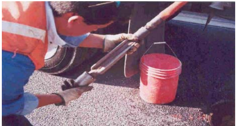
2.Preparación de la punta mecanismo para limpieza Fuente Industrias de Saneamiento y Desazolve, S.A. de C.V. Reproducción con fines académicos
