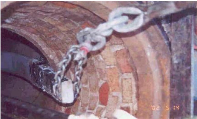
17.-Salida por el extremo contrario de la tubería colocada. Fuente Industrias de Saneamiento y Desazolve, S.A. de C.V.
