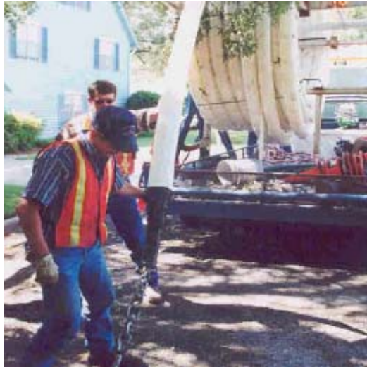
13.-Posicionamiento de tubería a instalar Fuente Industrias de Saneamiento y Desazolve, S.A. de C.V. Reproducción con fines académicos
