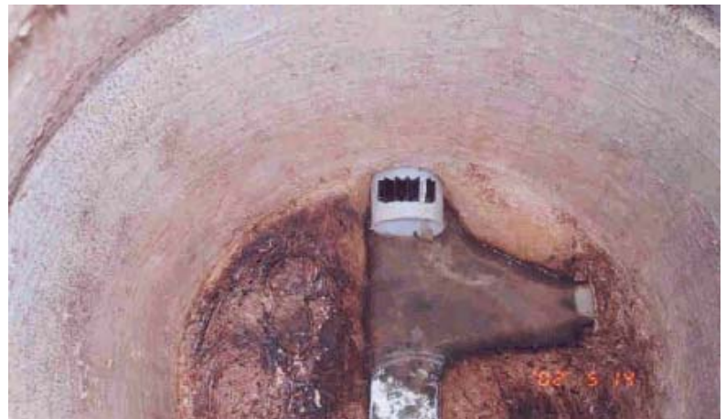
29.-Verificación de temperatura final y espesor Fuente Industrias de Saneamiento y Desazolve, S.A. de C.V. Reproducción con fines académicos
