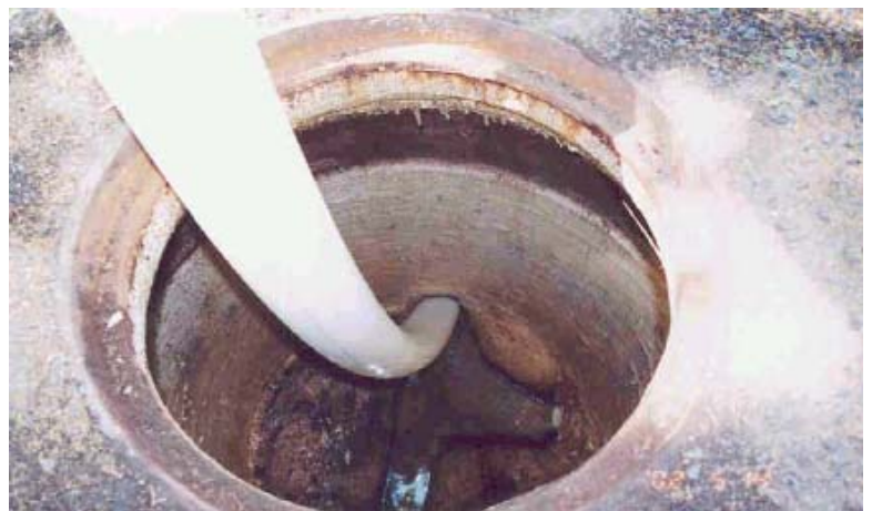
14.-Inicio de inserción del "u" liner Fuente Industrias de Saneamiento y Desazolve, S.A. de C.V. Reproducción con fines académicos
