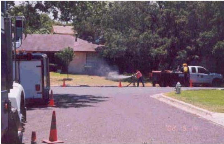
23.-Vista panorámica del proceso de colocación sin cierre de vialidad Fuente Industrias de Saneamiento y Desazolve, S.A. de C.V. Reproducción con fines académicos
