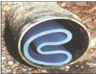
Tubería en U de polietileno de alta densidad en tubería anfitriona
