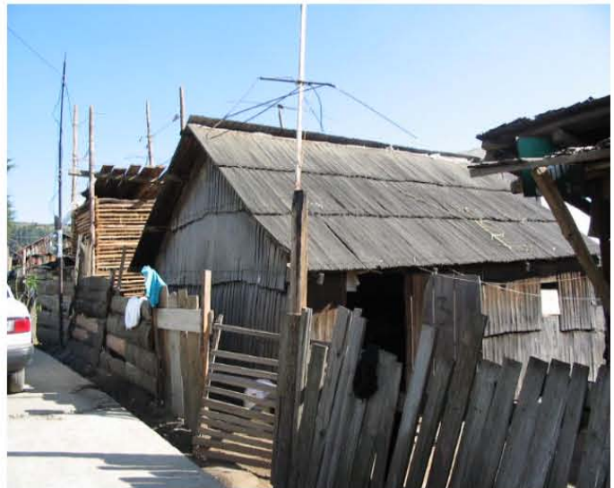
La vivienda de tejamanil esta en riesgo de desaparecer. Foto GTZ
