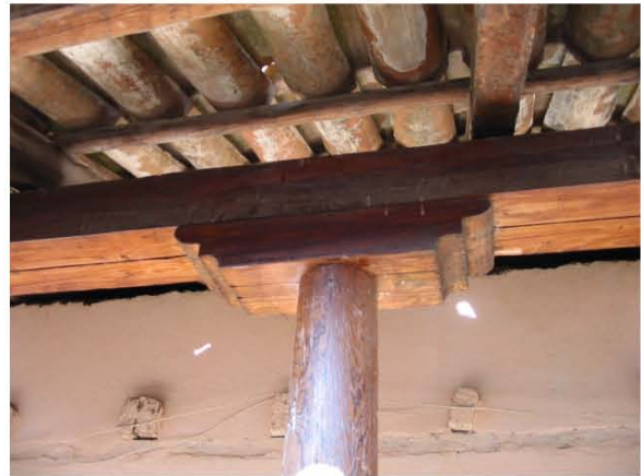
Los elementos arquitectónicos otorgan un carácter original a la vivienda vernácula. Fotos GTZ
