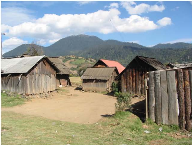
Vivienda de tejamanil, material que casi ha desaparecido. Ocuilan Foto GTZ
