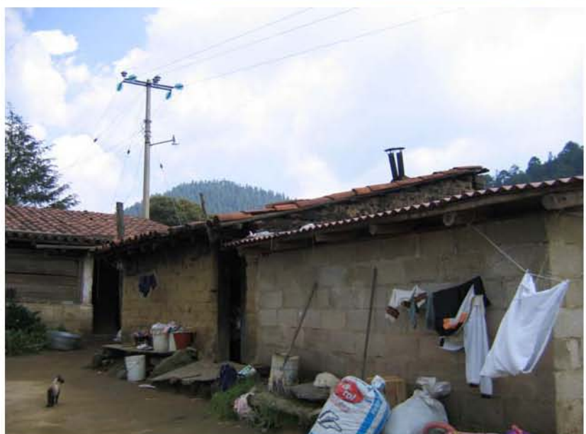
Los volúmenes del aposento y cocina definen el espacio del patio. Municipio de Xalatlaco. Foto GTZ
