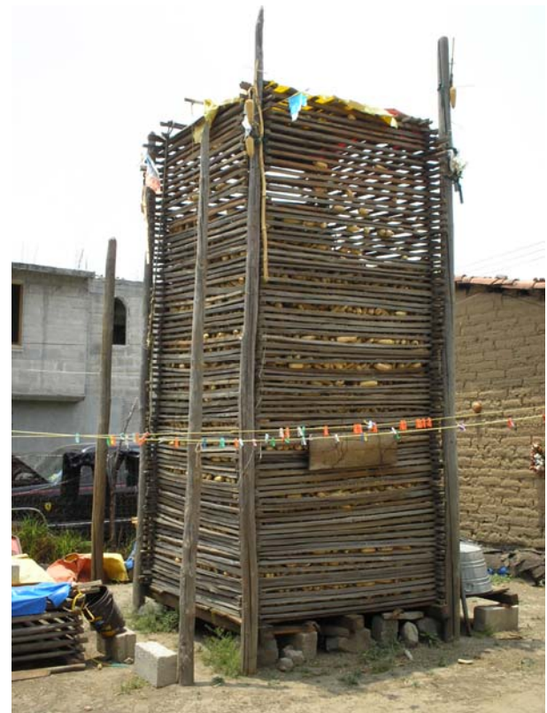
Vista de un zincolote, vivienda en Mexicaltzingo Foto GTZ
