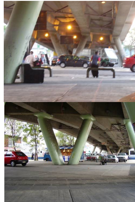
Fig. 17 El área bajo el puente es tan amplia que permite la ubicación de una cancha de Básquetbol y una zona de descanso.
