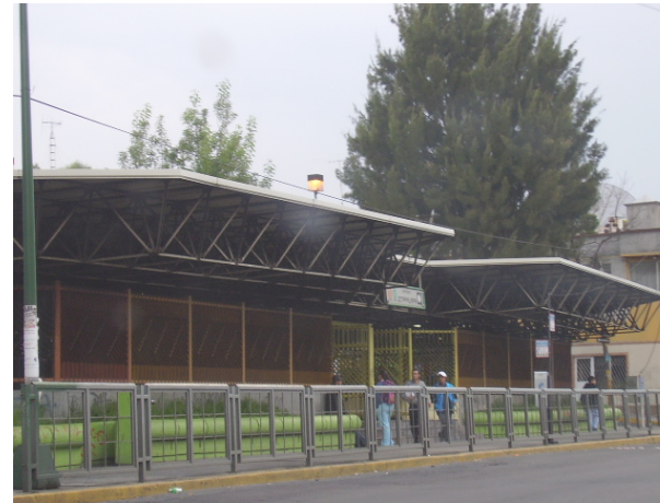
Fig. 23 Edificio de acceso a la estación en Av. Ermita Iztapalapa. El acceso no cuenta con un área vestibular.
