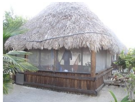
Foto 72. Vista hacia un bungalow.
