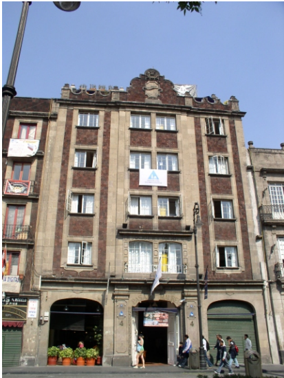
Foto 85. Fachada del hostel.
