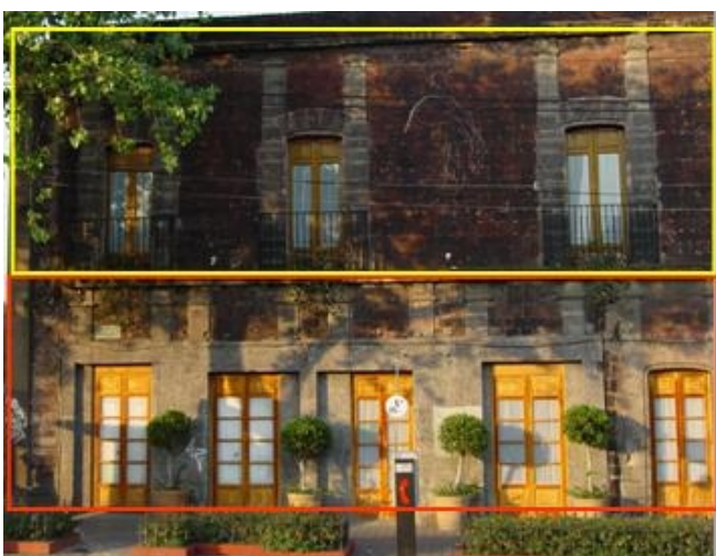
Foto 55. Fachada Sur del Hotel Cortés
