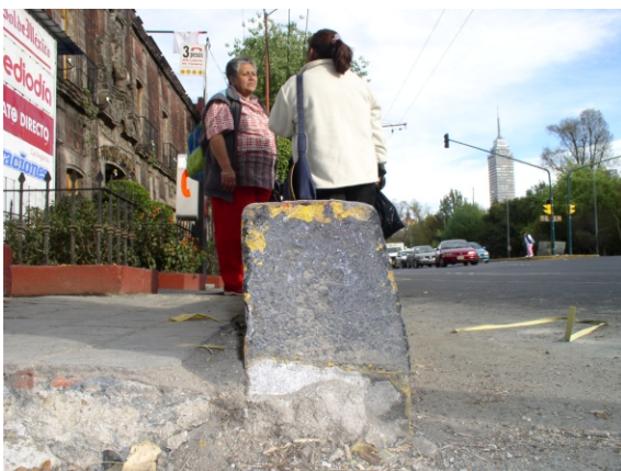
Foto 52. Banqueta en su sección trasversal.
