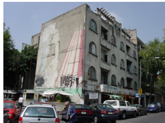
Foto 4. Relingo sobre reforma.
