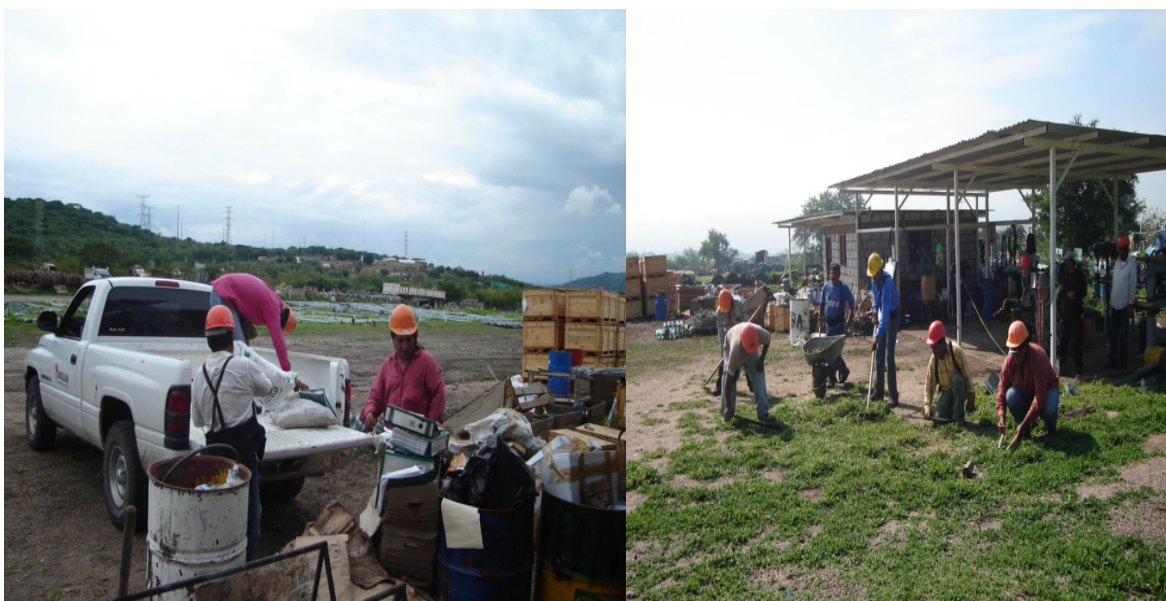
Figura 23: Almacén de obra Yautepec Morelos.
