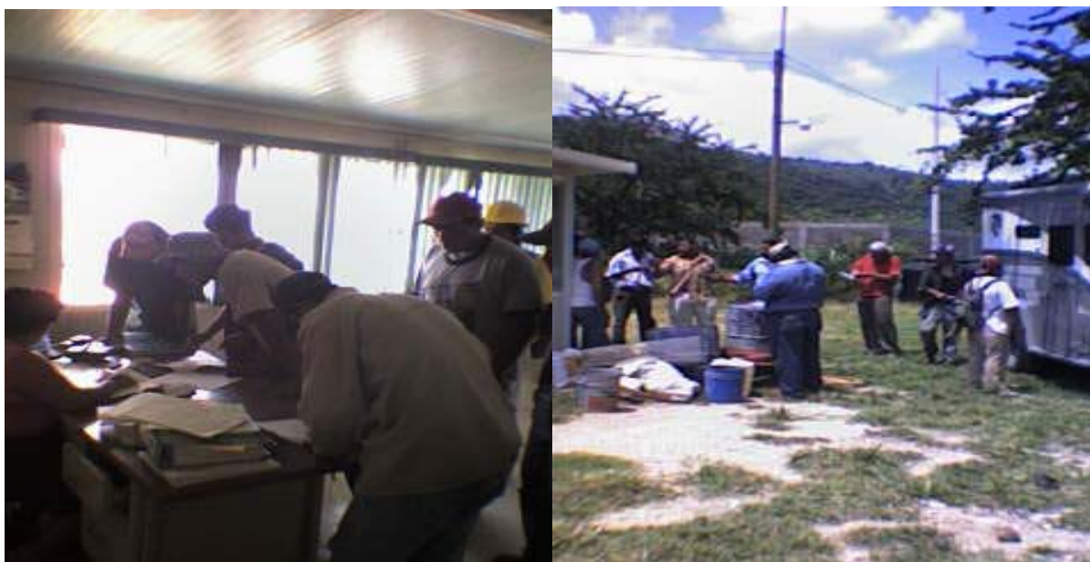
Figura 11: Pago de nómina a trabajadores en el almacén de obra Yautepec Morelos.
