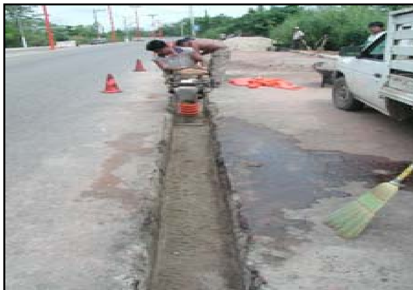
FOTOGRAFÍA V.6 “COMPACTACIÓN EN ZONA URBANA”
