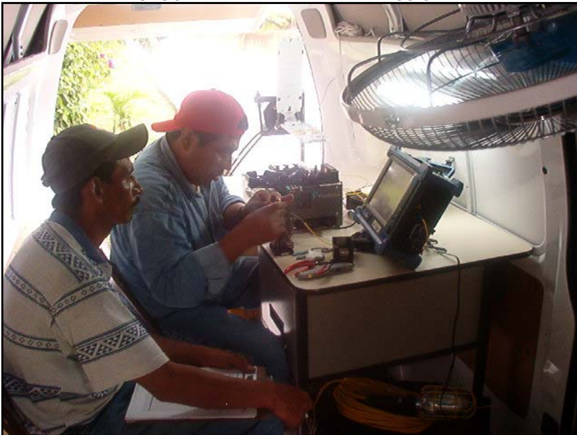
FOTOGRAFÍA V.1 “EMPALME DE FUSIÓN”
