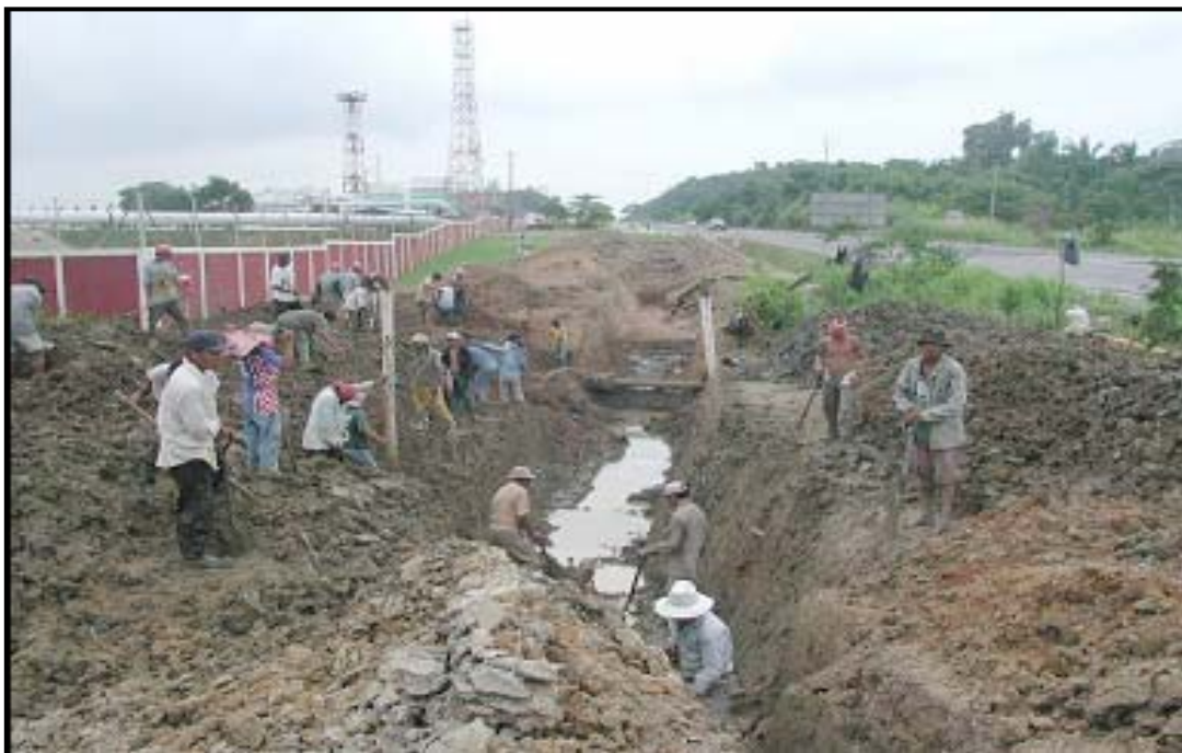
FOTOGRAFÍA V.5 “EXCAVACIÓN A MANO EN DERECHO DE VÍA”
