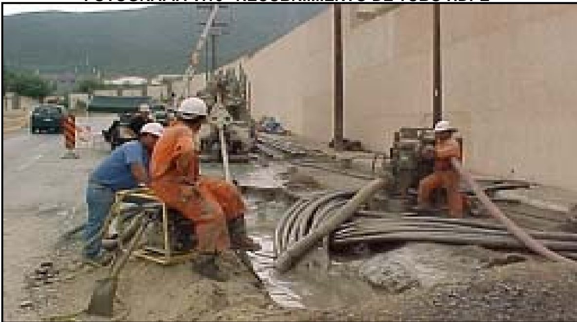
FOTOGRAFÍA V.10 “RECUBRIMIENTO DE TUBO HDPE”
