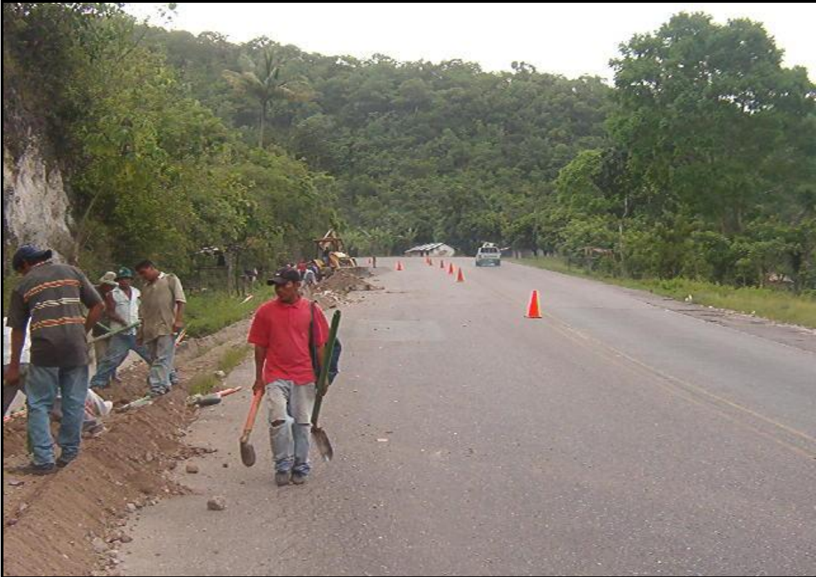
FOTOGRAFÍA VI.1 “MANO DE OBRA UTILIZADA PARA ZANJEAR”
