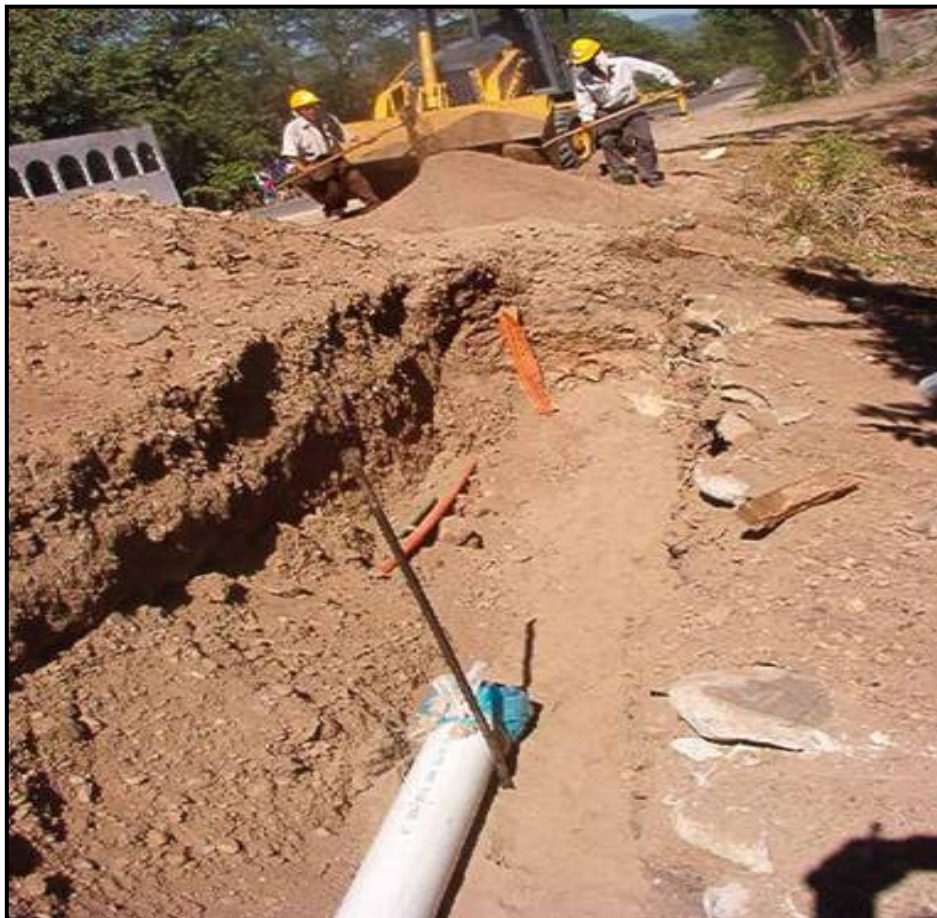
FOTOGRAFÍA V.25 “RELLENO Y SELECCIÓN DE MATERIAL”
