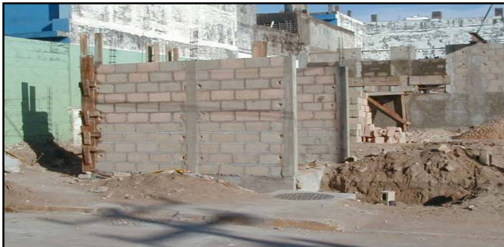
FOTOGRAFÍA V.30 “MURO DE LADRILLO CUATROPEADO”
