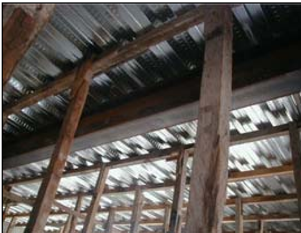
FOTOGRAFÍA V.29 “CIMBRA EN LOSACERO”
