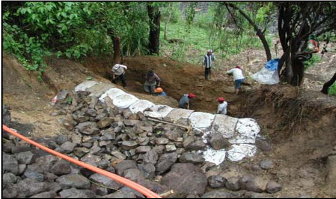
FOTOGRAFÍA V.11 “CONTROL DE EROSIÓN MEDIANTE GAVIONES”
