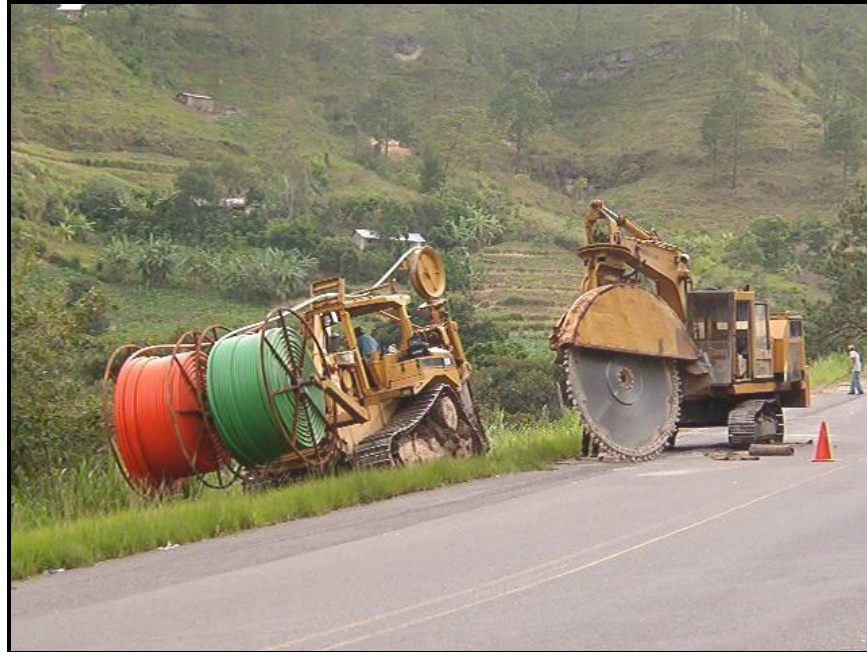
FOTOGRAFÍA VI.6 “TENEDORA DE CABLE DE FIBRA ÓPTICA Y PETRATERRA”
