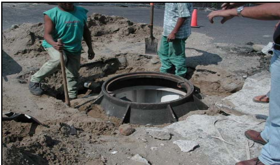
FOTOGRAFÍA V.12 COLOCACIÓN DE CÁMARA MANHOLE
