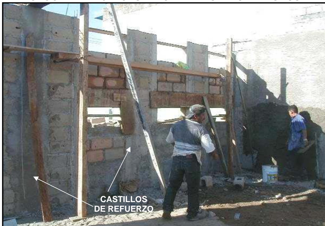
FOTOGRAFÍA V.31 "CASTILLO DE REFUERZO EN MUROS"
