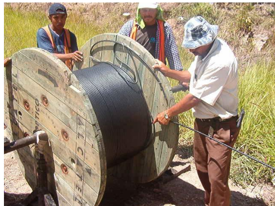
Inmersión de Cable de Fibra Óptica
