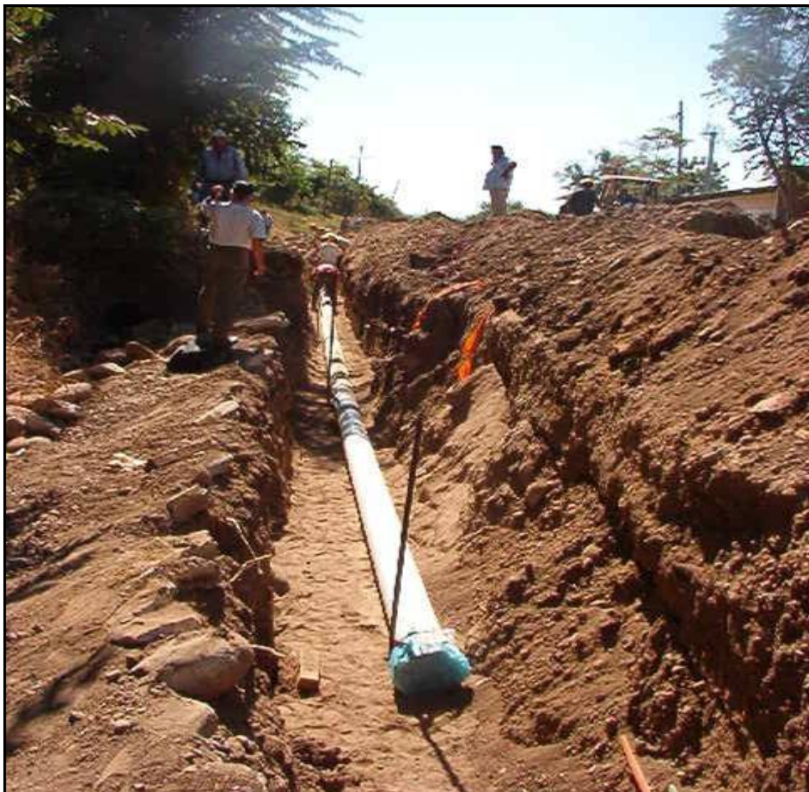
FOTOGRAFÍA V.24 “COLOCACIÓN DE TUBO DE PVC”
