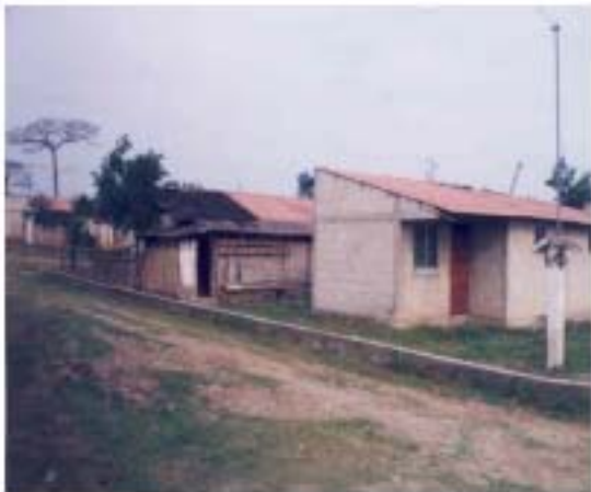
FOTO 5. Ampliación de las viviendas.
