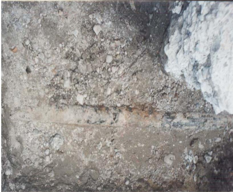
Fotografía 2.9 Condiciones actuales de la infraestructura de la red de distribución en las calles del centro de la ciudad. La imagen nos muestra el deterioro de las tuberías.
