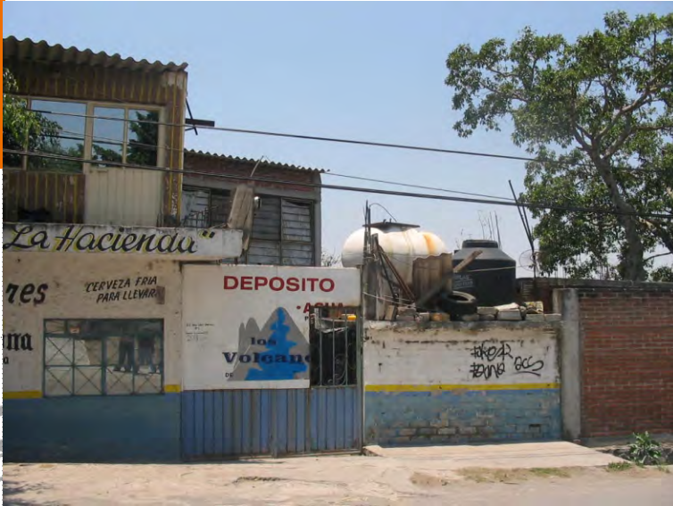
Imagen: construcción habitacional con comercio.
