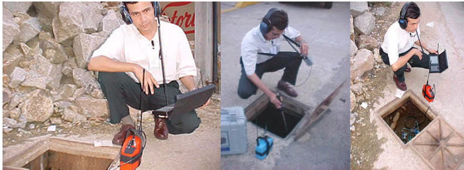
Figura 7 Equipo Hidrométrico de alta tecnología para la detección de fugas no visibles.
