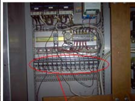
Contactores de 24 Vc.d. que sirven como drives de los contactores de mayor potencia
