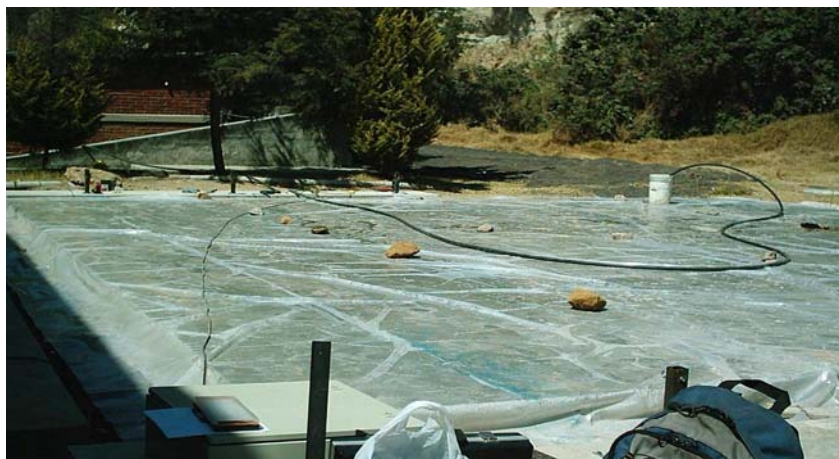
Figura 2.4 Curado de la losa
