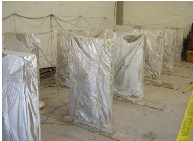
Figura 2.13 Curado de losas
