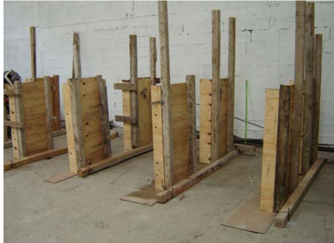
Figura 2.11 Cimbra de las losas verticales
