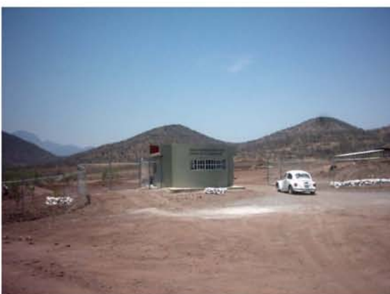
Caseta de vigilancia, entrada al terreno y cercado perimetral del CITIRS.
