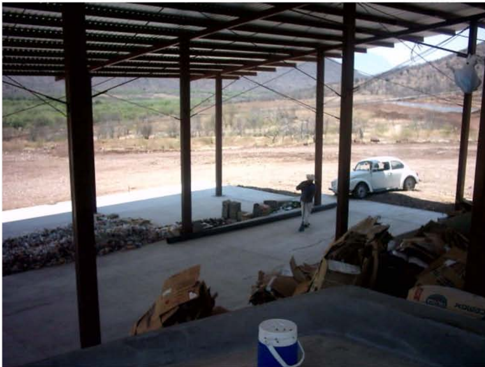
INTERIOR DE LA TECHUMBRE PARA SEPARABLES, EN ETAPA DE EXPERIMENTACIÓN, VISTA CENTRO-SUR.- LA HUACANA
