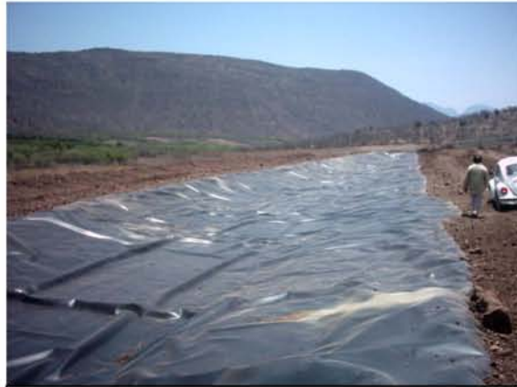
Área de confinamiento final de los residuos sólidos sanitarios, la basura y lo que se pueda aprovechar lo que modifica el volumen calculado de un proyecto.
