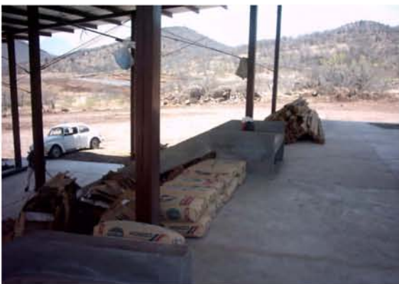
Interior de la techumbre para separables, en etapa de experimentación.
