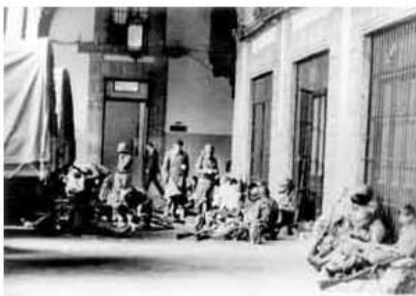
Figura 9. Después del bazucazo en la Preparatoria Uno y la brutalidad de los soldados contra los estudiantes, la tropa descansa en el patio de la escuela. En: http://www.jornada.unam.mx/2005/10/02/mas-jesus.html
