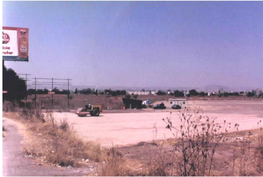
Figura 3.2.2. Compactación del terreno
