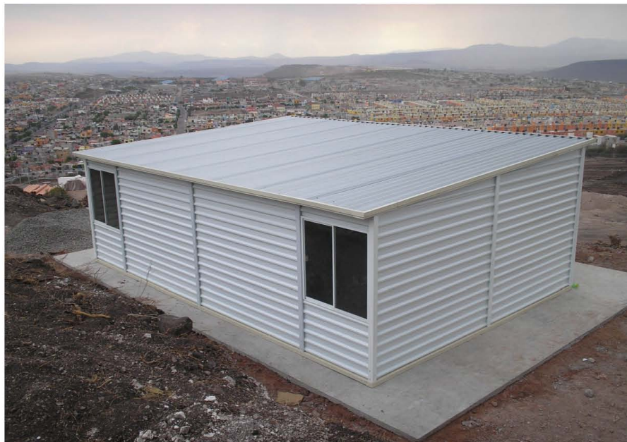
Figura 1.2.1. Foto de una casa habitacional en la Ciudad de México.
