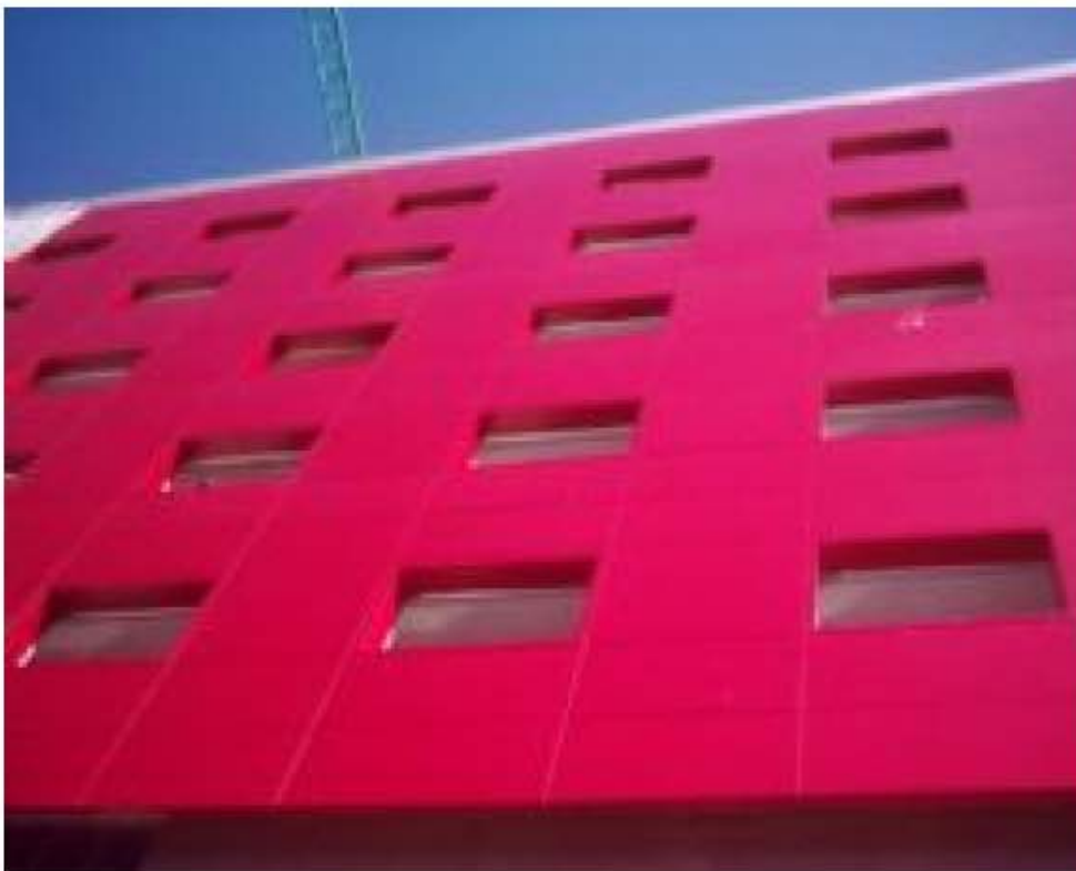
FIGURA 1.2.15. Elementos portantes de fachadas en el Hotel Acosta Centro, 4 Estrellas en Almendralejo, España.
