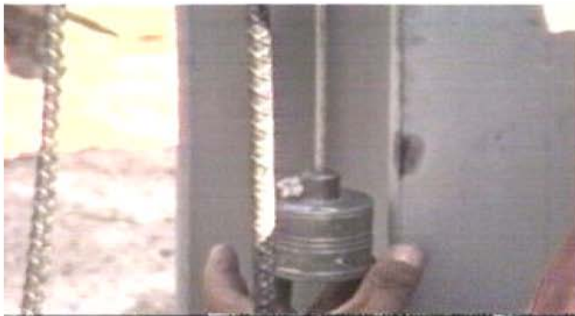
Figura 3.3.1. Plomeo en muros
