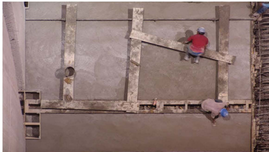
Figura 3.2.3. Colado de plantilla de concreto pobre
