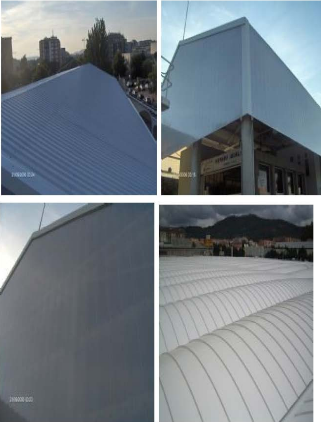
Figura 1.2.14. Estación de autobuses en Iguala, Barcelona.
