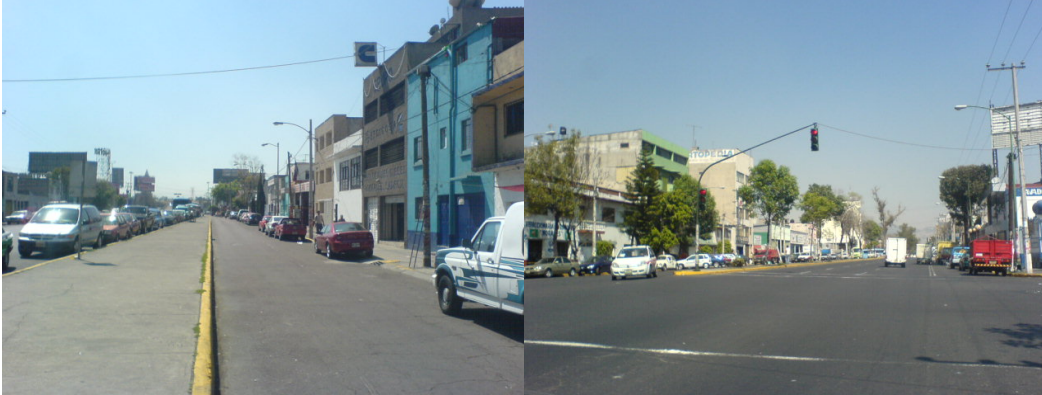
Vista de la zona sur del Corredor "Politécnico"
