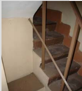
ESCALERA DE 1er. A 2o. Nivel
