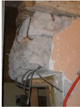
Demolición de elementos estructurales originales.
