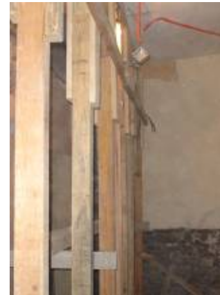
Apuntalamiento de losas y elementos estructurales.
