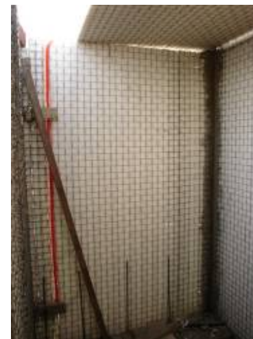
Armado de muros con panel mediante malla unión y esquineros. Las instalaciones no van sobre elementos estructurales.
