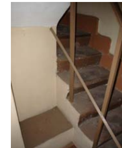
ESCALERA DE 1er. A 2o. NIVEL
