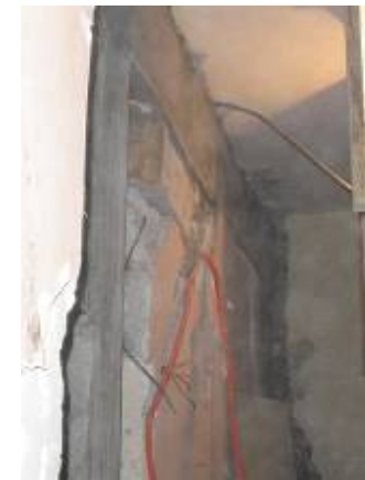
Nuevas columnas y traveses ya coladas. Se quitaron los puntales después de un mes.
