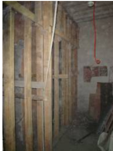
Se pusieron puntales para sostener todas las losas mientras se hacían las nuevas columnas y traveses.
