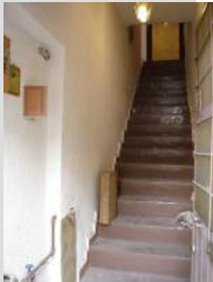
Escalera en acceso principal.
