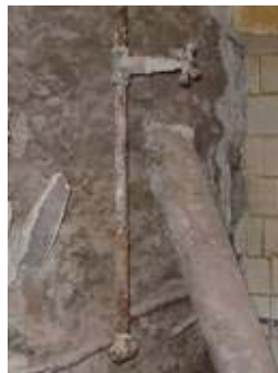
INSTALACIÓN ELÉCTRICA E HIDRÁULICA – ESTADO ACTUAL
