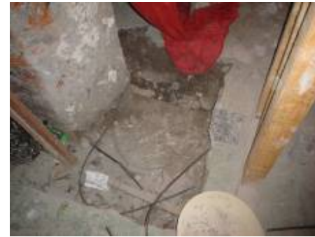
Demolición de losa y muros para encontrar cimentación donde anclar nuevas columnas.
