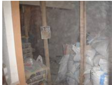
Apuntalamiento de losas y elementos estructurales.
