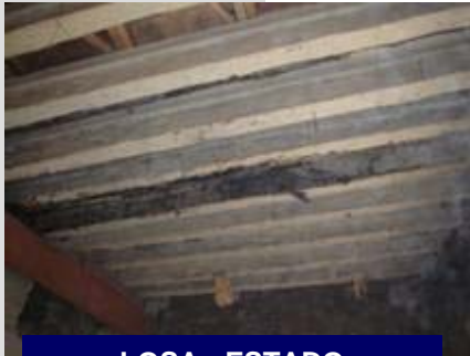
LOSA - ESTADO ANTERIOR
