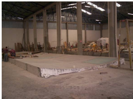
Mesas de colado
