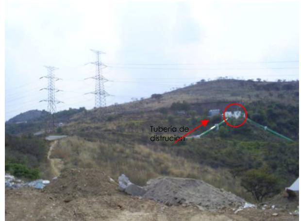
Distribución de agua potable (se encuentra ubicada a 100 mts del terreno y es la que abastece la zona)
