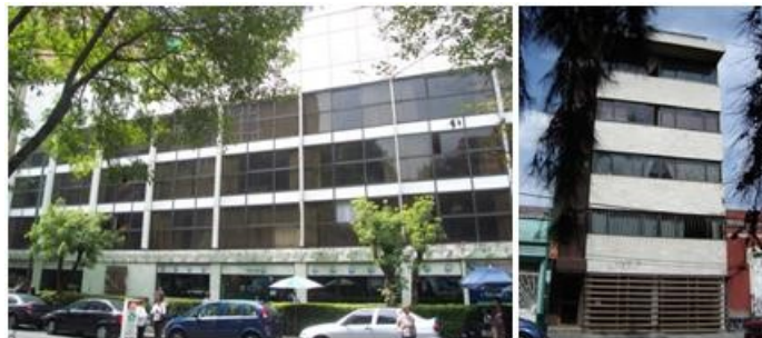
Figura 9.- Sistema de marcos de concreto
