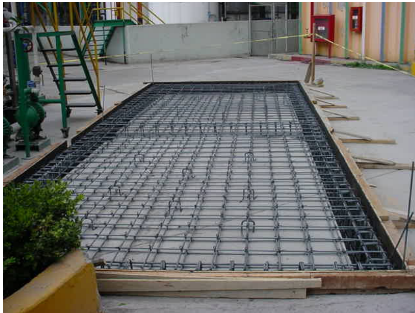
Figura C.13 Habilitado de cimbra y acero de refuerzo para base del Sistema de Flotación por Aire Disuelto (Disolved Air Flotation DAF)
