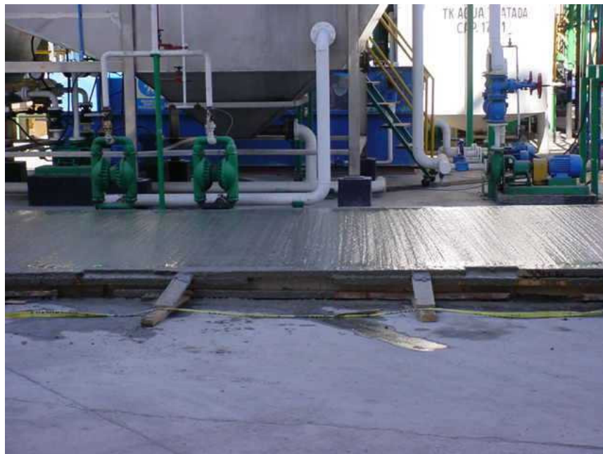
Figura C.14 Concreto premezclado para base del Sistema de Flotación por Aire Disuelto (Disolved Air Flotation DAF)
