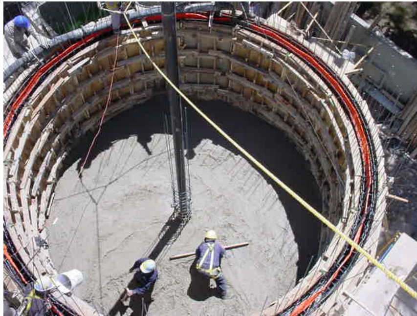
Figura C.7 Colado de elementos del filtro percolador.
