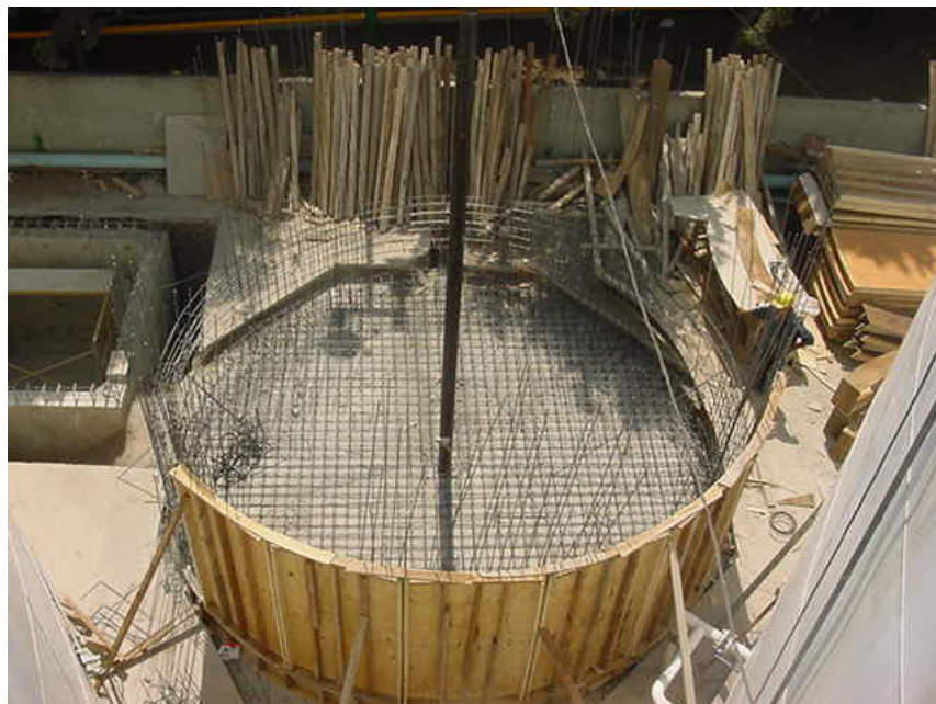
Figura C.4 Plantilla y armado de la parrilla de la base del filtro percolador.
