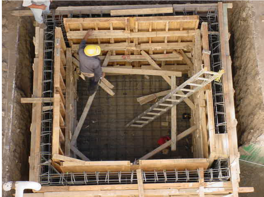
Figura C.11 Habilitado de cimbra y acero de refuerzo para construcción de tanque de bombeo.
