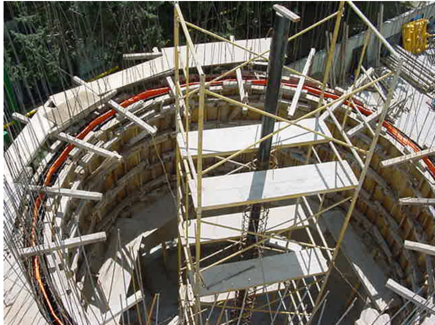
Figura C.9 Colocación de tubo de acero al carbón cédula 40, de 152 mm (6 pulgadas) de diámetro.
