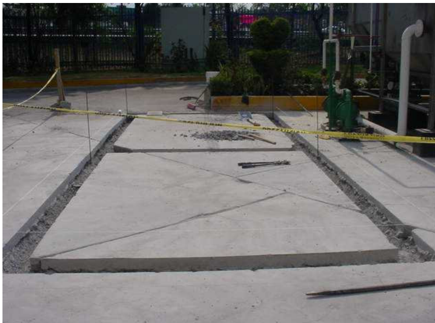
Figura C.12 Demolición de piso de concreto armado para desplante de Base del Sistema de Flotación por Aire Disuelto (Dissolved Air Flotation DAF)
