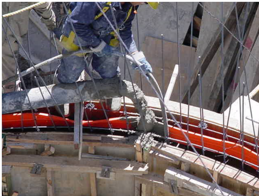
Figura C.8 Colado de elementos del filtro percolador y colocación de banda de PVC de 152 mm (6 pulgadas) en juntas frías.
