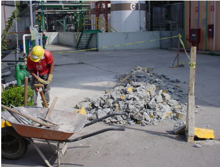
Figura C.1 Demolición de piso de concreto armado de 20 a 25 cm. de espesor.
