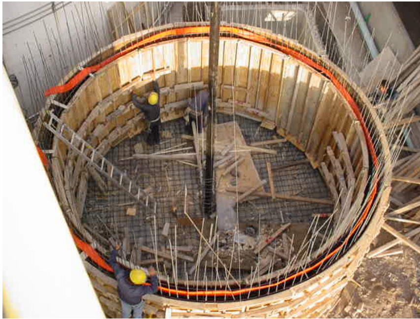
Figura C.5 Habilitado de cimbra y colocación de banda de PVC de 152 mm (6 pulgadas).
