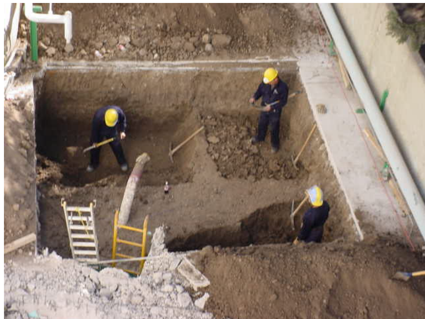
Figura C.10 Excavación en material Tipo II para construcción de Tanque de Bombeo.
