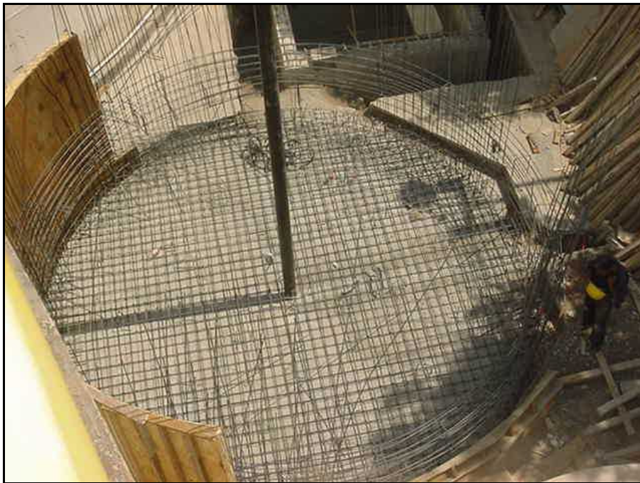
FIGURA IV.2 “HABILITADO DE ACERO DE REFUERZO EN FILTRO PERCOLADOR”
