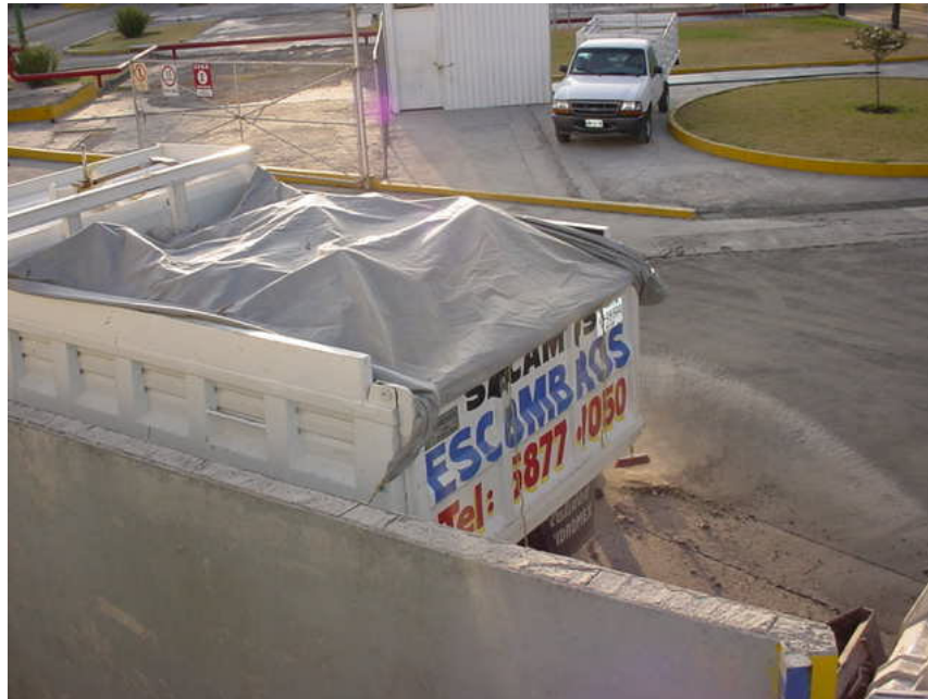
Figura C.3 Retiro y acarreo de escombros fuera de obra.
