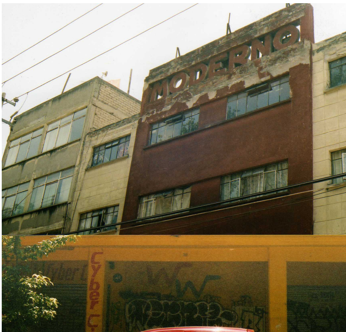
FACHADA DE LO QUE FUE EL CINE "MODERNO" DE LA COLONIA DEL VALLE EN LA CALLE DE MIER Y PESADO
