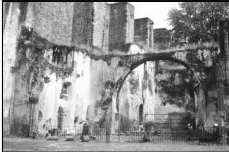
② Presentación de humedad, vegetación y hongos en muros exteriores, disgregación y ruptura de la piedra.
