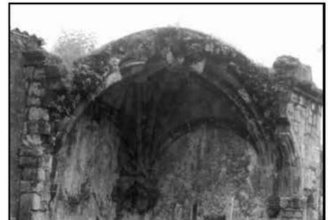
③ Presentación de humedad, vegetación y hongos en muros exteriores, disgregación y ruptura de la piedra.
