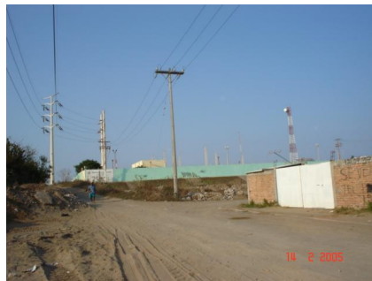
Fig.53 Comisión Federal de Electricidad, Boca del Río.
