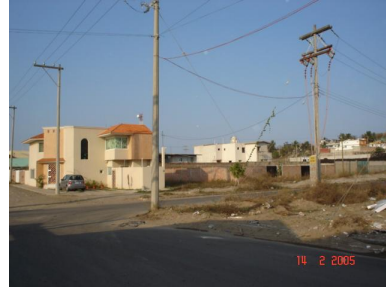
Fig.48 Poste de luz en la esquina del terreno
