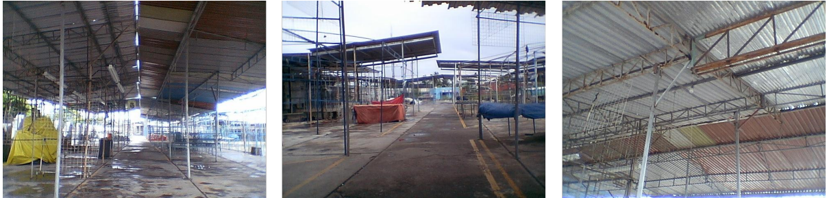
Fig.34 Vista de la cubierta Fig. 35 Vista del interior Fig.36 Detalle de estructura
