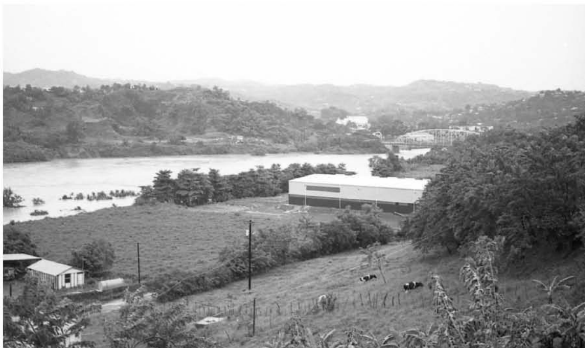
Fig. 124. Toma dirección suroeste. Obsérvese al fondo el antiguo puente que conectaba la carretera PR- 181 y el pueblo de Trujillo Alto.
