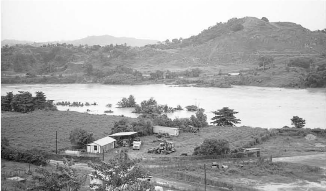
Fig. 125. Toma dirección sureste. Obsérvense los árboles casi completamente sumergidos bajo agua.
