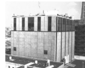
Puesto Central de Control I.
