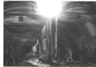
Estación excavada en doble nivel subterráneo.
