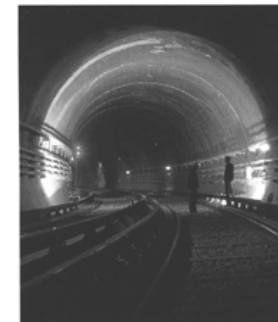
22. Tramo de vía con curva subterránea.
