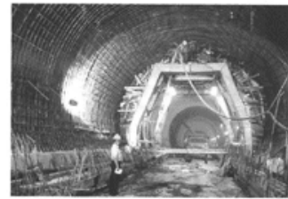
Cimbro del túnel.
