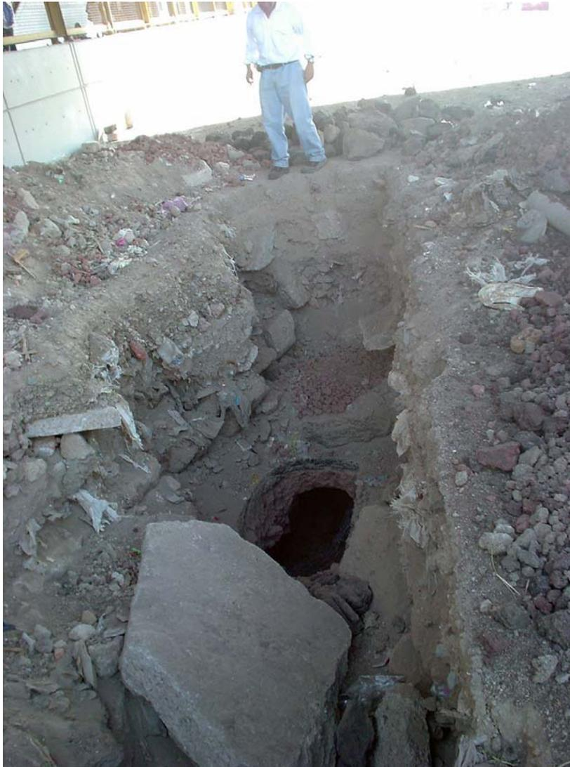
Fig. 4.24. Fotografía de la excavación sobre las líneas de adquisición R01, R30a y R30b que muestra una canaleta que origina las anomalías en las secciones de GPR
