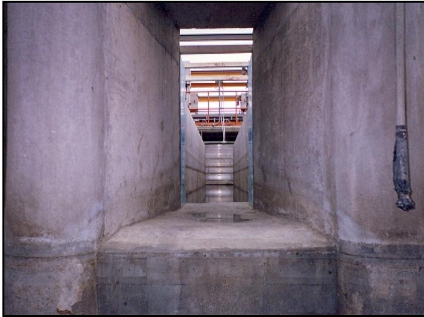
Figura V.24. Área de la sección transversal de uno de los tres canales venturís para la medición del gasto influente en la Planta Norte. Obsérvese al lado derecho el electrodo para la medición del parámetro potencial de hidrógeno
