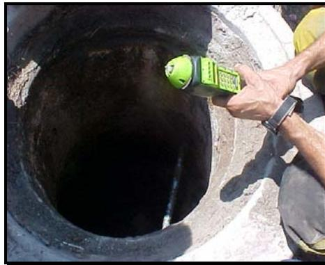
**Figura IV.1. Seguimiento monitorio del nivel de explosividad, como LEL (lower explosivity level), en un pozo de visita de la red de alcantarillado**
