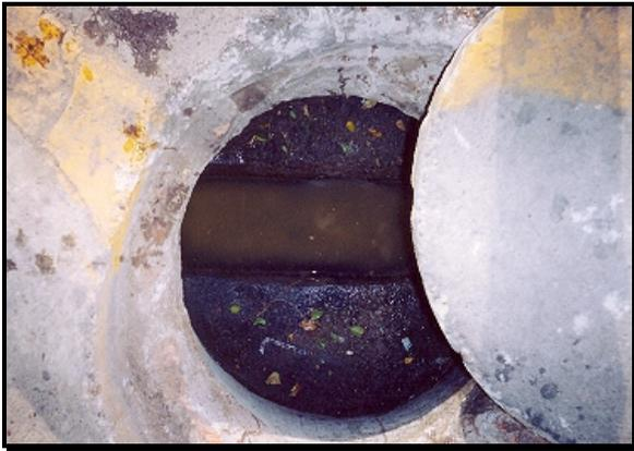
Revisión del registro de la descarga de un hospital conectada a la red de drenaje con el objeto de proceder a realizar un muestreo compuesto de 24 horas, así como la medición de los gastos instantáneos
