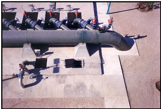
Figura V.20. Tanque de la estación de bombeo Rubí, obsérvese el cabezal de descarga y las válvulas de admisión y expulsión de aire
