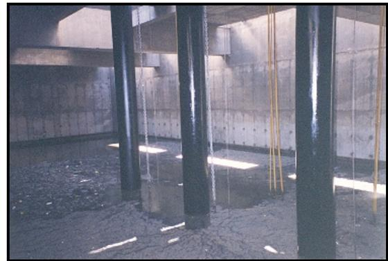
Figura V.21. Tubería de descarga de las bombas sumergibles ubicadas en el tanque de la estación de bombeo Rubí
