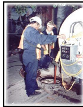
Figura V.6. Desazolve de un pozo de vista mediante un camión tipo "vactor", debido a obstrucción por presencia de grasas y aceites
