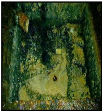
Figura V.5. Trampa para grasas y aceites de un establecimiento de comida rápida, azolvada por falta de limpieza
