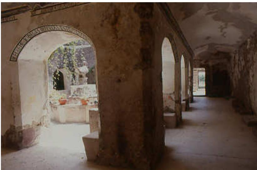
Figura 23. Claustro de San Juan Bautista Cuauhtinchan, Puebla, el que al parecer carece de banquetas y en cambio evidencia un pavimento, en este caso recubrimiento de un enlucido de cal-arena.
