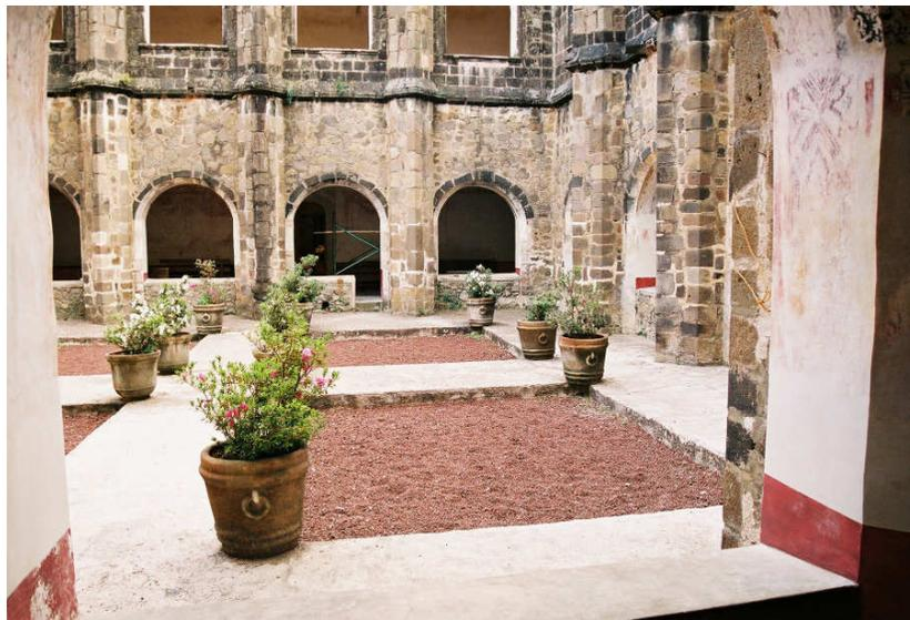
Figura 34. Patio de Tetela del Volcán con banqueta perimetral, centrales, cuadrantes y filtros en cada cuadrante. La habilitación de los filtros ha permitido desalojar gran parte del agua, remediando paulatinamente el daño causado al edificio.
