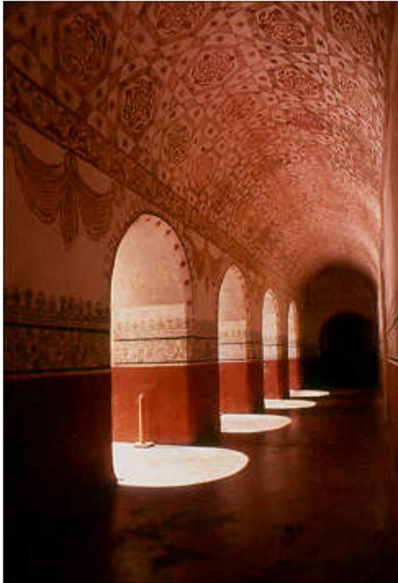
Figura 29. Corredor norte del claustro del convento de la Natividad Tepoztlán, donde el ancho del pasillo guarda una relación modular con el claro de los arcos y la altura del lecho interno de los cañones.
