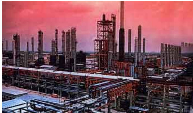
Figura 1. Vista preliminar de la Refinería de Salamanca
