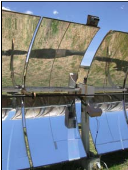
Figura 4.26. Colocación de sensores de intensidad luminosa.
