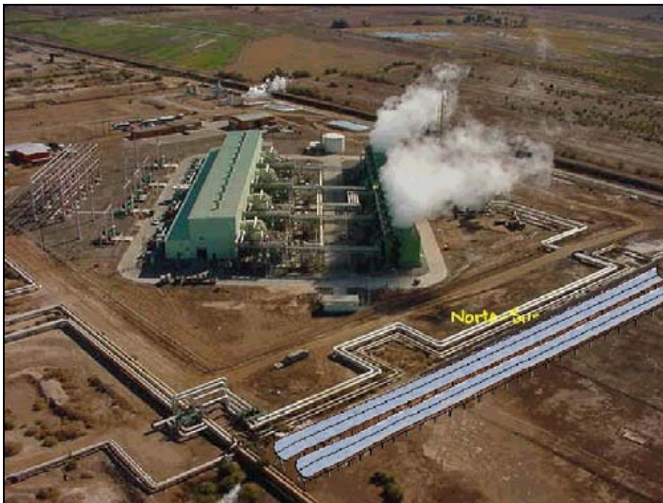
Figura 5.18. Sistema híbrido geotérmico-solar.
