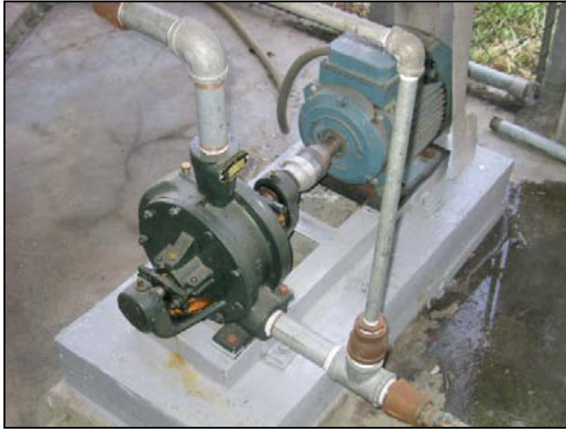
Figura 3.50. Conjunto motor-bomba de suministro.
