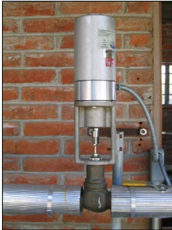
Figura 4.36. Montaje de la válvula de apertura proporcional.
