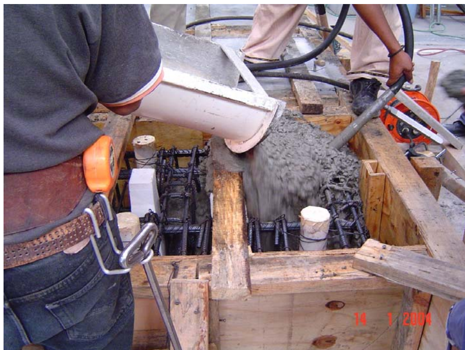
Figura 2.18. Colado de cimentación
