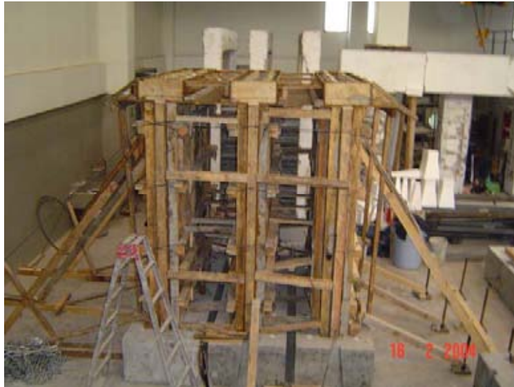
Figura 2.24. Muros cimbrados antes del colado
