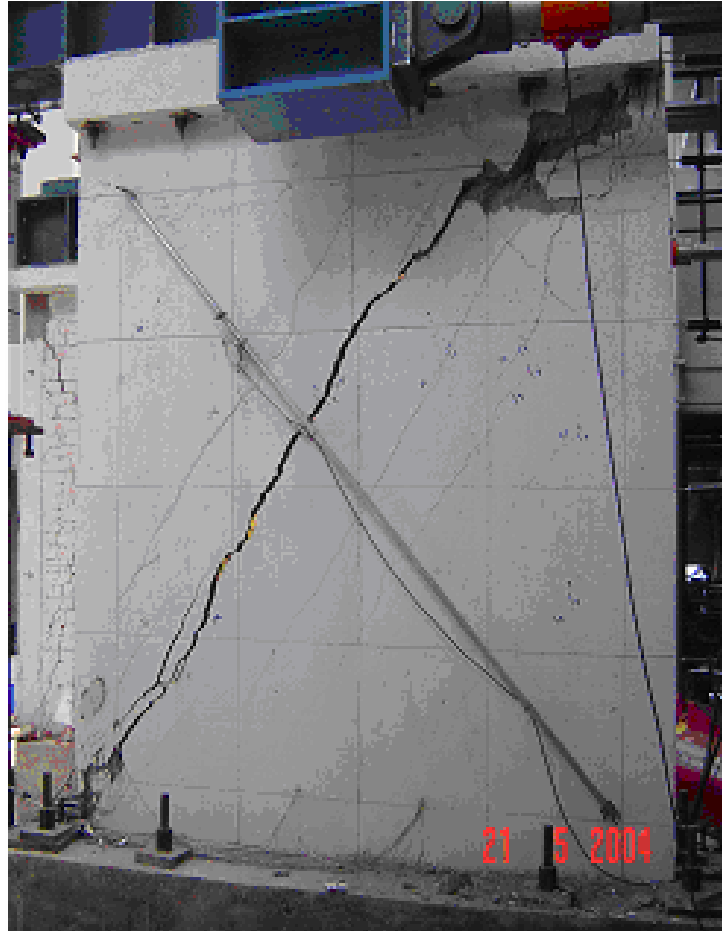
Figura 3.18. Agrietamiento al momento en el que se llegó a la carga máxima
