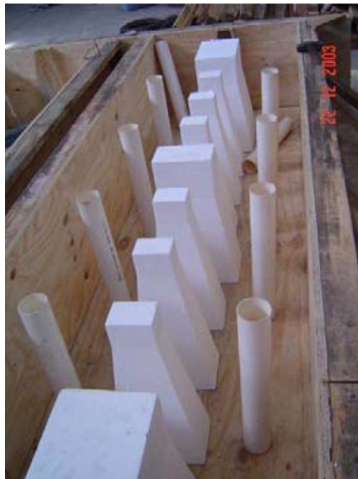
Figura 2.16. Configuración de elementos p/dejar huecos
