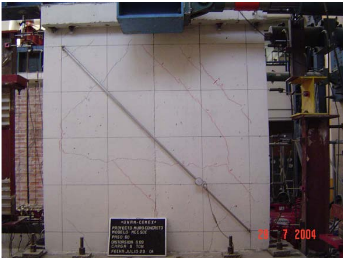
Figura 3.36. Estado del muro MCC50C para una distorsión de 0.09%
