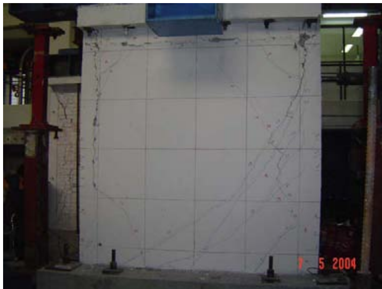
Figura 3.10. Estado final del muro MCC0M
