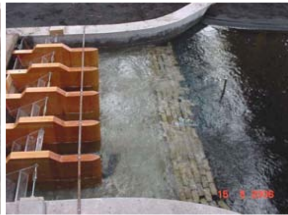
Fig. 5.22 Distribución de la corriente de agua a la salida de las pilas.
