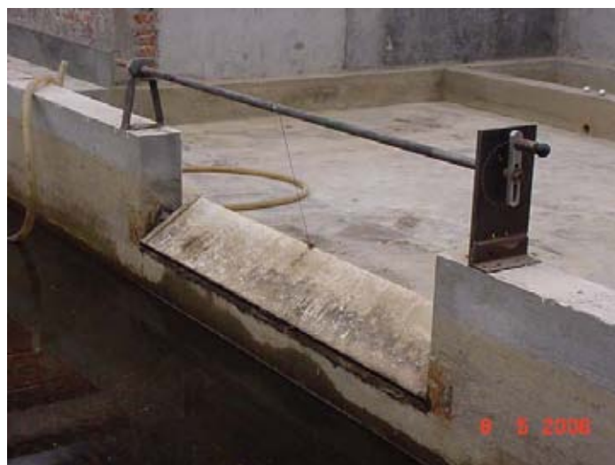
Fig. 2.7 Compuerta tipo abatible.
