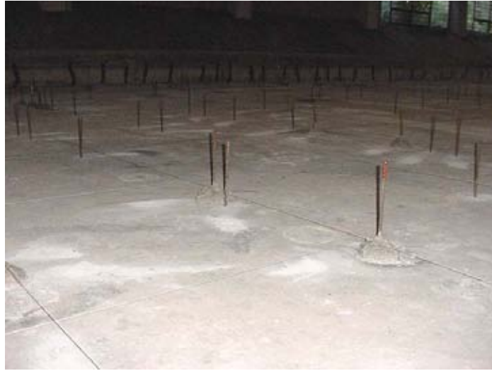
Fig. 2.4 Identificación de varillas de acuerdo al nivel batimétrico
