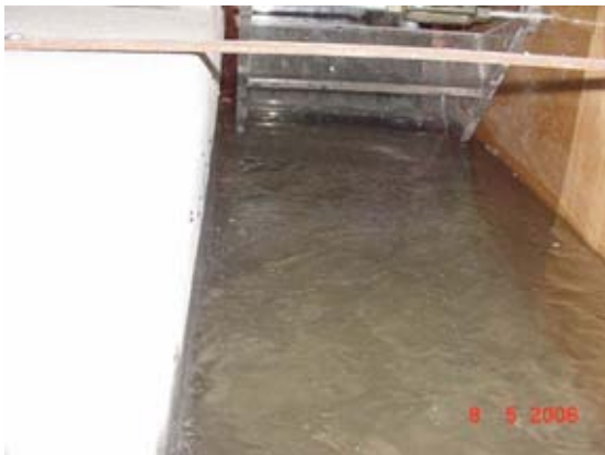
Fig. 5.12 Disturbios detrás de la compuerta
