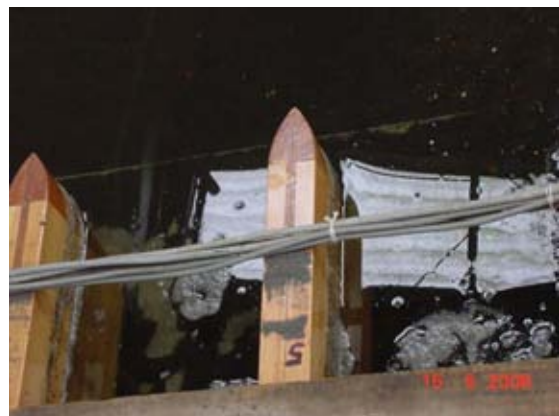
Fig. 5.20 No existen vórtices en la nariz de las pilas 3,4 y 5
