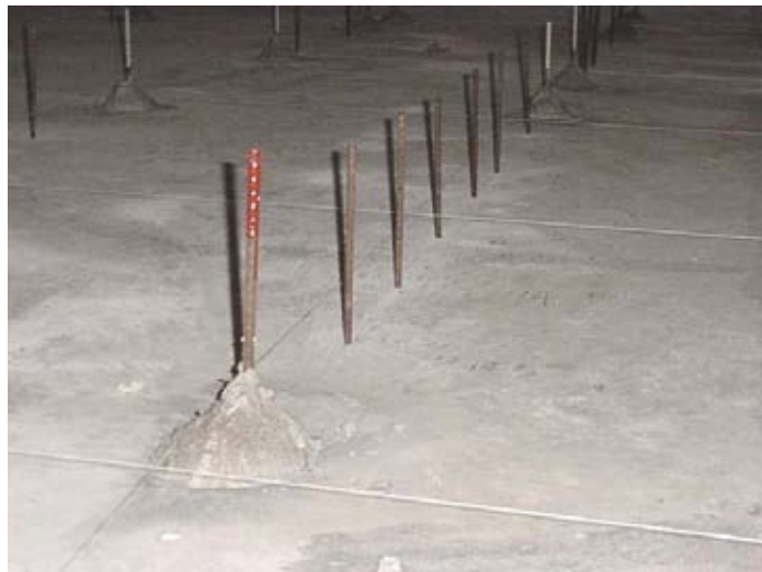
Fig. 2.5 Nivelación de las varillas para configurar la batimetría
