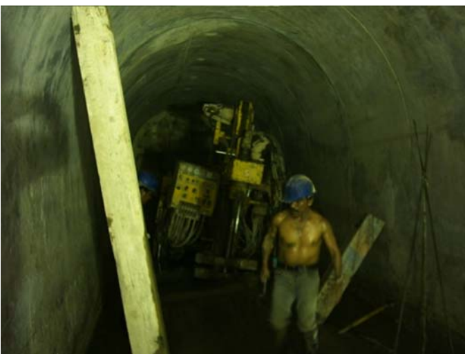
Foto. 4 Perforación en plinto (track drill)
