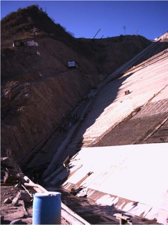
Foto. 1 Vista del Plinto (margen izquierda)
