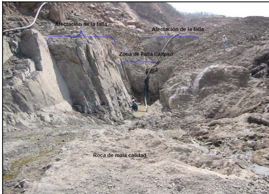
Falla Calipso en el cauce del río, viendo hacia aguas arriba.
