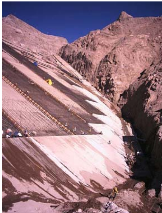
Foto. 2 Vista del Plinto (margen derecha)
