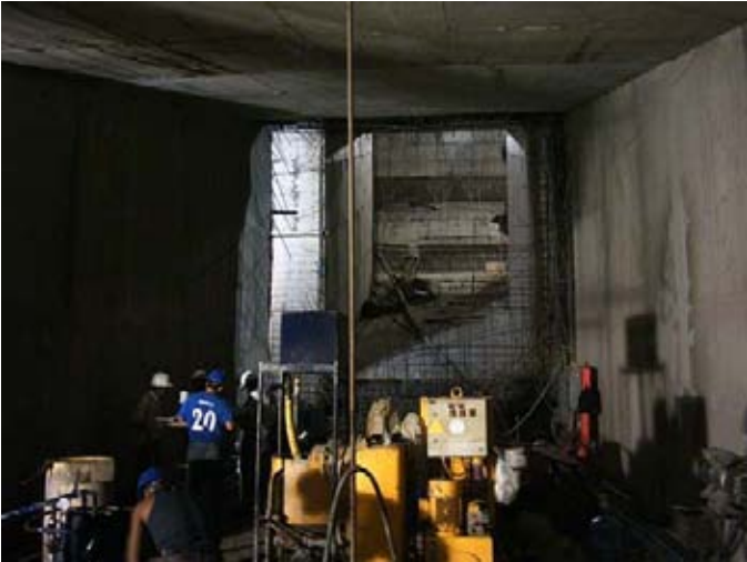
Foto. 6 Inyección en Codo de Aspiración
