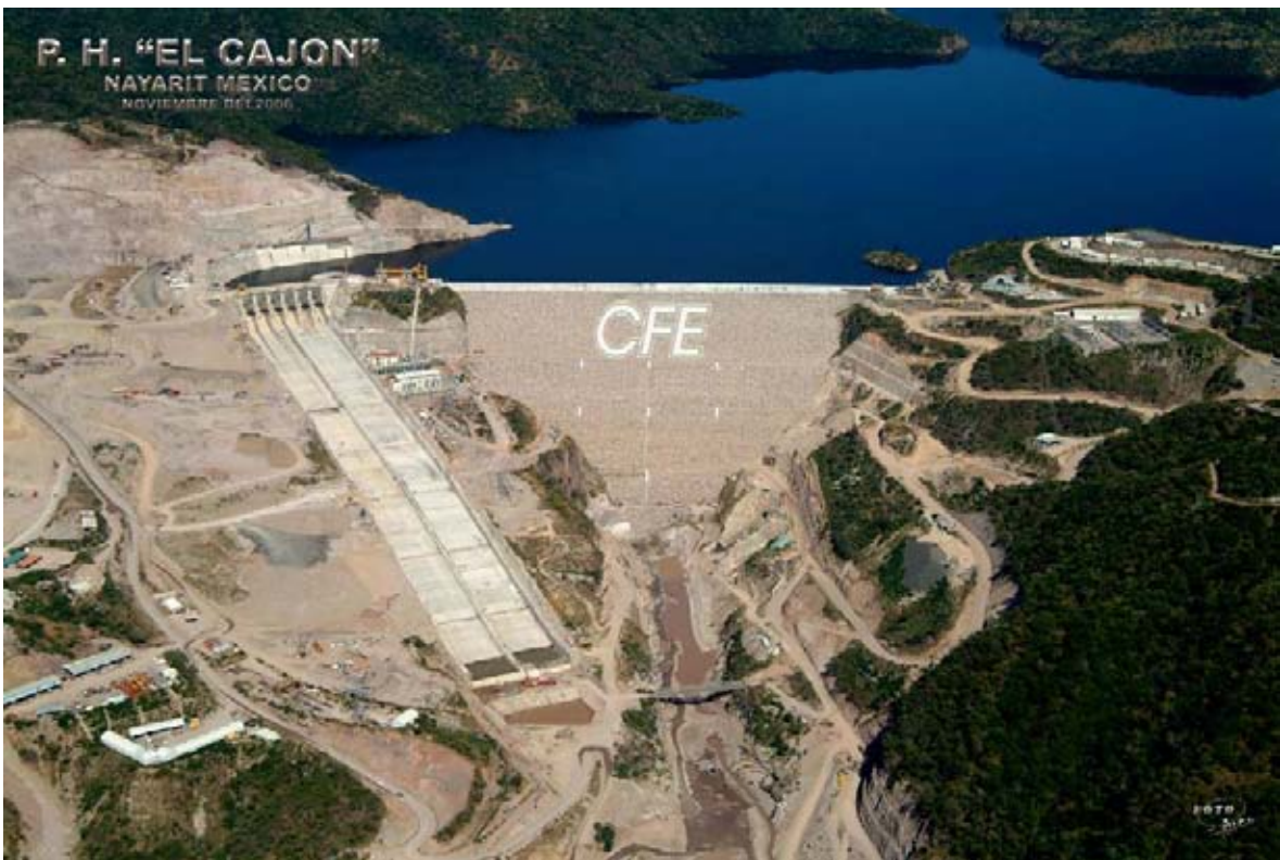
Foto 11. Vista General del Proyecto (Noviembre 2006).
