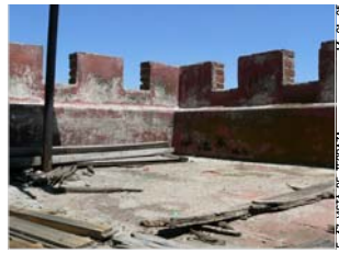
F-46 DETALLE DE TORRE 14-01-05
