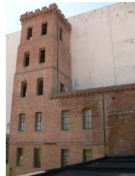
Imagen 222.- Vista actual del exterior de la torre de tabique de seis niveles de altura.
