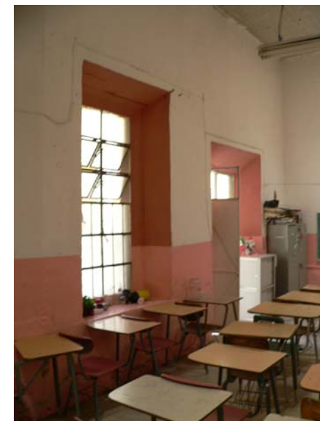
Imagen 220.- Vista actual del interior de alguna de las recámaras de la casa habitación, convertida en salón de clases.
