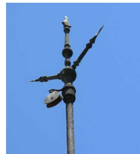
Imagen 229.- Punta del asta original colocada en la azotea de la torre de tabique.
