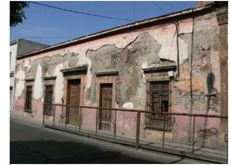
Imagen 128. — Vista exterior de casa habitación. Calle 5 de febrero #305.
