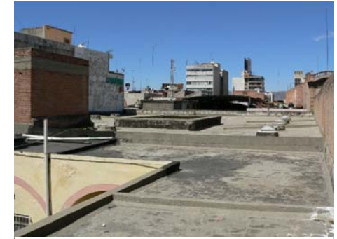
Imagen 262.- Vista de la azotea de la casa que se propone aprovechar para ubicar el anexo y así ampliar los espacios de uso.
