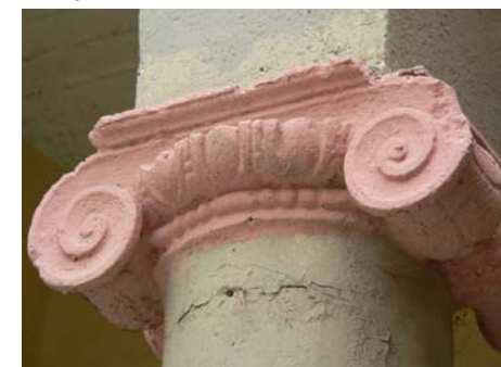
Imagen 244.- Capitel de orden jónico en las columnas del portal del patio.
