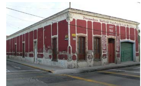
Imagen 112.— Vista exterior de casa habitación. Calle Hidalgo esquina con Calle Lerdo de Tejada.
