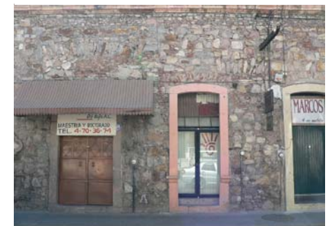
Imagen 190. — Ejemplo de muro fabricado en calicanto. Calle Pedro Moreno esquina con Calle La Paz.
