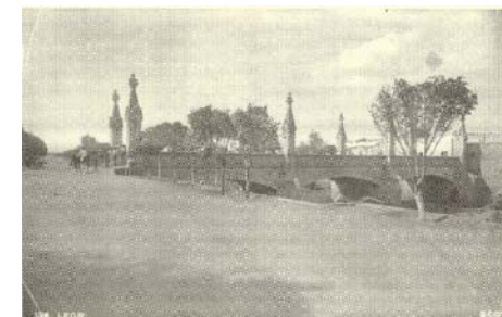
Imagen 212. – Puente Barón y Morales, también llamado del Coecillo. Tomado de Labarthe Ríos, María de la Cruz, Louis Long .
