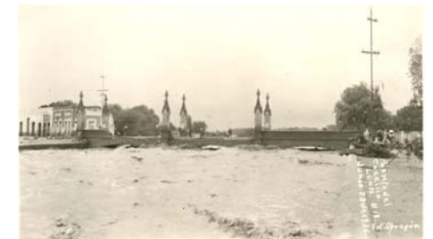
Imagen 103. — Crecida del Río de los Gómez a la altura del Puente Barón o del Coecillo durante la inundación de 1926. Tomado de colección particular.
