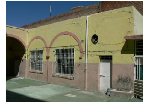
Imagen 239.- Vista actual del exterior del pórtico del segundo patio.
