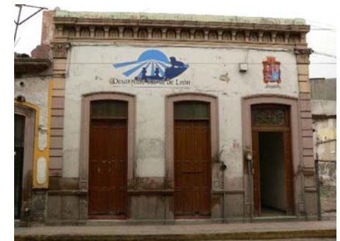
Imagen 162.- Fotografía de casa habitación de un nivel. Calle 5 de Febrero #217.
