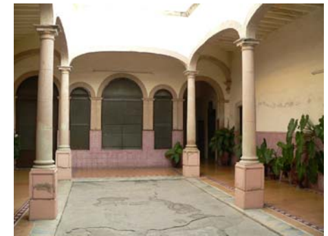
Imagen 129. — Vista del patio principal de casa habitación. Calle Aquiles Serdán S/N.
