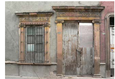
Imagen 179.- Ejemplo de marcos de cantera en vanos de fachada. Calle Hidalgo #340.
