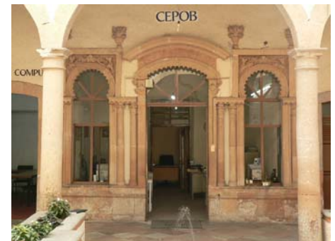
Imagen 187.- Ejemplo de marcos de cantera para puerta y ventanas de comedor. Calle Pedro Moreno esquina con Calle La Paz.
