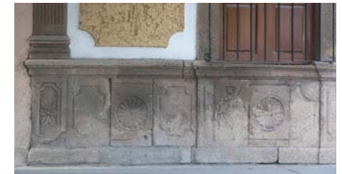
Imagen 178.- Detalle de guardapolvo de cantera en fachada. Calle Juárez #444.
