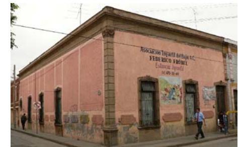
Imagen 121.— Vista exterior de casa habitación. Calle 5 de Febrero esquina con Calle Ignacio Altamirano.
