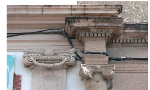
Imagen 177.- Detalle de cornisas y remates de pilastras en fachada. Calle Independencia #137 y 139.
