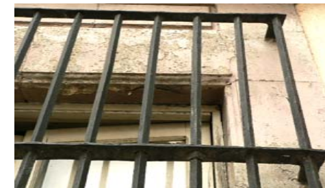
Imagen 201. — Ejemplo de reja remachada. Calle 5 de febrero #510.
