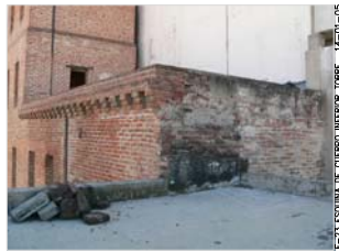
F-23 ESCUINA DE CUERPO INTERIOR TORRE 14-01-05
