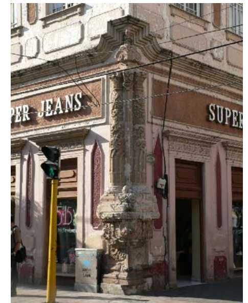
Imagen 14. — Columna decorativa en esquina con rasgos barrocos del siglo XVIII, en León. Calle 5 de Mayo esquina con Calle Pedro Moreno.
