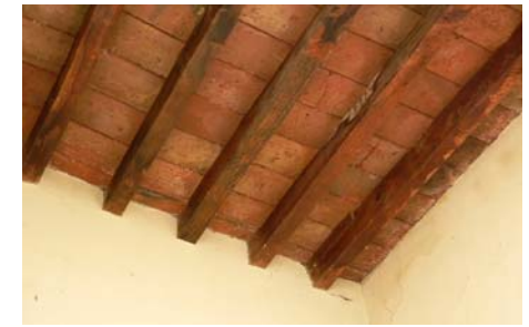
Imagen 194. – Ejemplo de techumbre de vigería de madera y loseta de barro. Calle Pedro Moreno esquina con Calle Donato Guerra.
