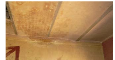
Imagen 197. – Ejemplo de techumbre en bóveda catalana. Calle Pedro Moreno #208.
