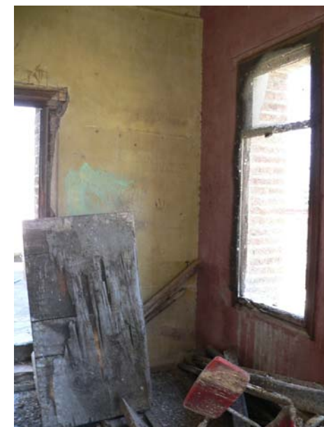
Imagen 223.- Vista actual del interior de una de las habitaciones dentro de la torre de tabique.
