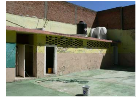
Imagen 252.- Vista de los volúmenes agregados para albergar los baños.
