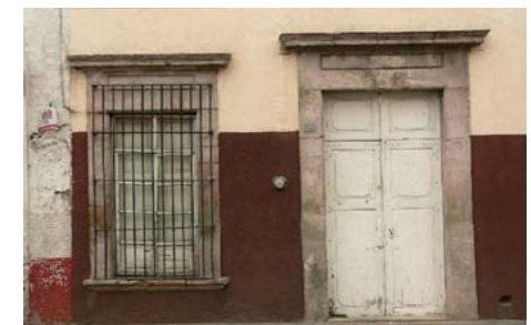
Imagen 180.- Ejemplo marcos de cantera en vanos de fachada. Calle 5 de febrero #510.
