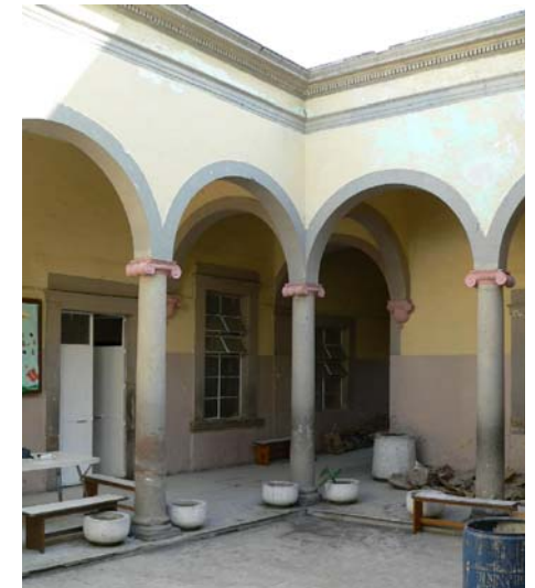
Imagen 245.- Vista actual del patio principal y sus pórticos.
