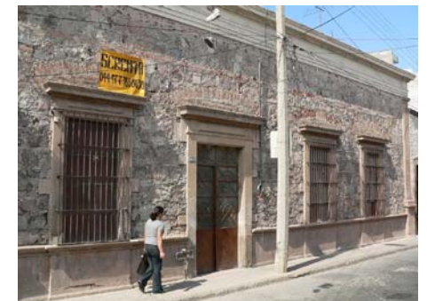
Imagen 193. — Ejemplo de muro fabricado en calicanto con arcos de tabique ahogados en él. Calle Ignacio Altamirano #106.
