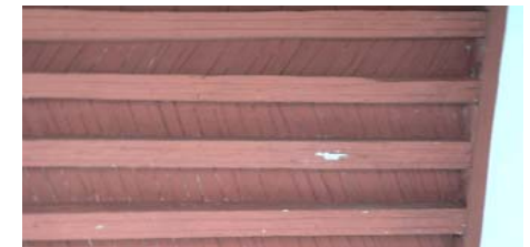
Imagen 196. – Ejemplo de techumbre de vigería de madera y tejamanil. Calle Pino Suárez #313.
