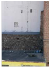
F-21 VISTA DE MURO DE PIEDRA 14-01-05
