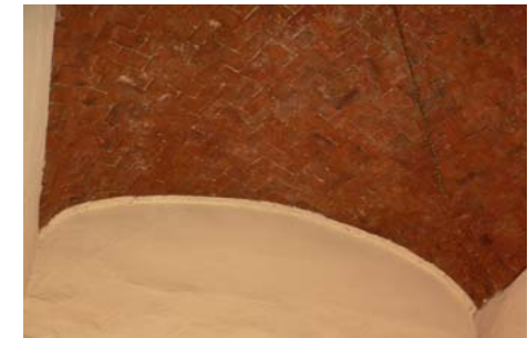
Imagen 195. – Ejemplo de techumbre en bóveda de tabique. Calle Pedro Moreno esquina con Calle La Paz.
