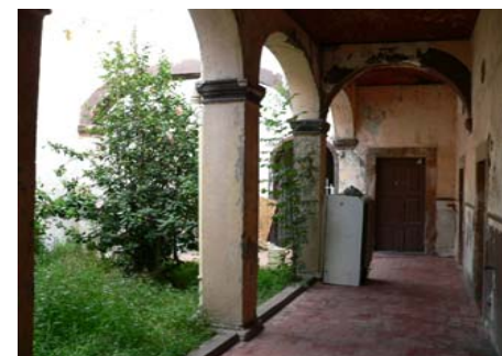
Imagen 117.— Vista del segundo patio de casa habitación. Calle Hidalgo #314.
