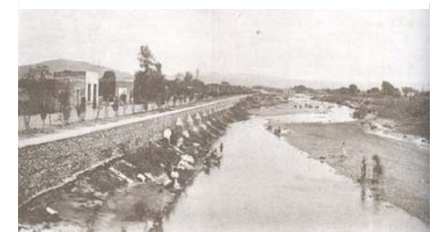
Imagen 98.— Río de los Gómez con el calicanto construido en su costado poniente, finales del siglo XIX. Tomado de González Leal Mariano, León trayectoria y destino .
