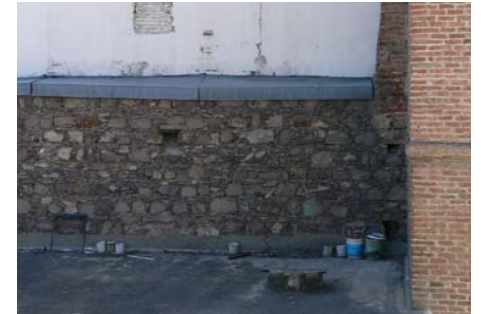
Imagen 248.- Muro fabricado en piedra ubicado en el segundo patio.
