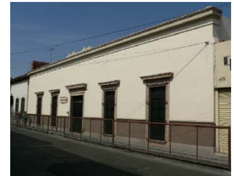
Imagen 169.- Ejemplo de fachada simétrica, reflejo del patio ubicado sobre el eje central del predio. Calle 5 de Febrero #311.
