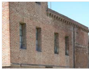
F-20 VISTA DE FAJALE DE SEGUNDO PISO TORRE 14-01-05
