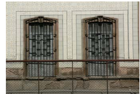
Imagen 200. — Ejemplo de muro recubierto con mosaico de pasta. Calle 5 de Febrero #309.
