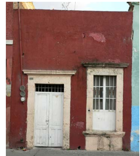
Imagen 130. — Vista exterior de casa habitación. Calle Aquiles Serdán #624.
