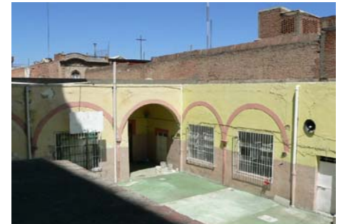
Imagen 249.- Vista actual del portal tapiado ubicado en el segundo
