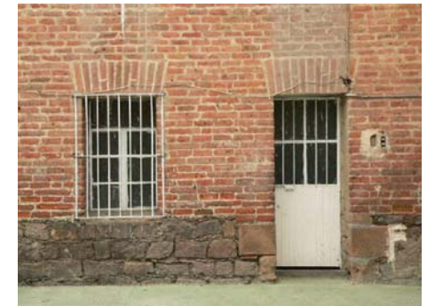
Imagen 188. — Ejemplo de muro fabricado en tabique recocado con arranque alto fabricado en calicanto. Calle Pedro Moreno #208.
