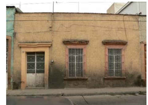
Imagen 171.- Ejemplo de fachada donde la puerta principal esta cargada a un extremo, reflejo del patio ubicado junto a la colindancia. Calle Independencia #316.
