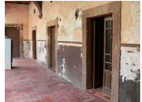
Imagen 186.- Ejemplo de marcos de cantera para puertas con un mismo modelo. Calle Hidalgo #314.
