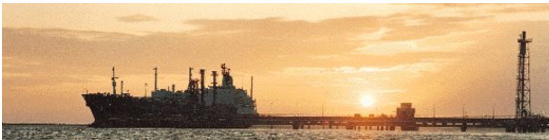
Fig. 4.1 Buque utilizado en la transportación de metano
