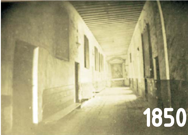
Corredor de Bachilleres 11
