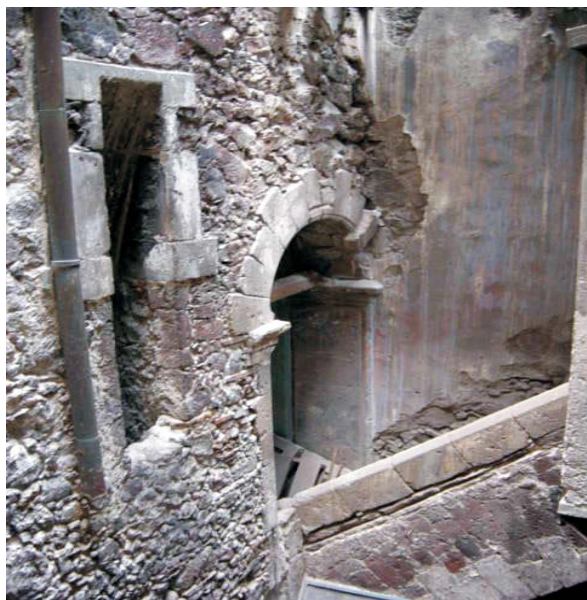
MATERIALES BASE DE LA CASA NO.5/REGINA NO. 97 6
