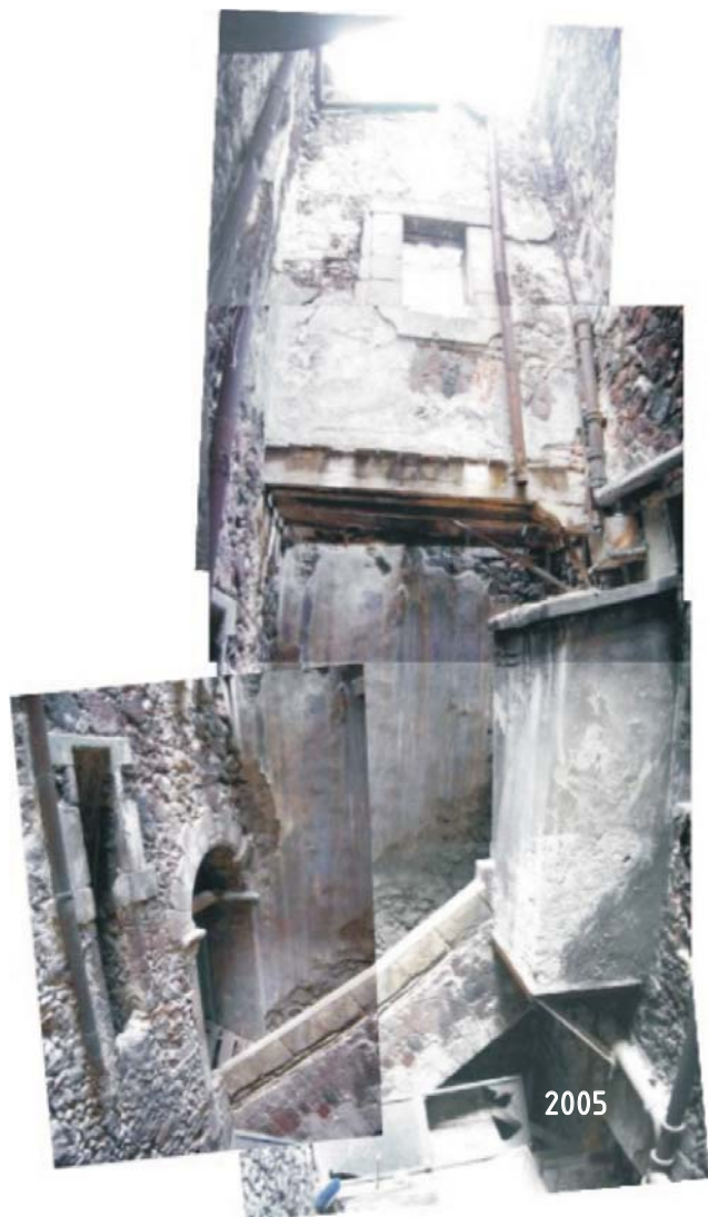
PEQUEÑO PATIO INTERIOR Y BIFURCACIÓN DE ESCALERA HACIA VIVIENDA, CASA NO.5/REGINA NO. 97 10
