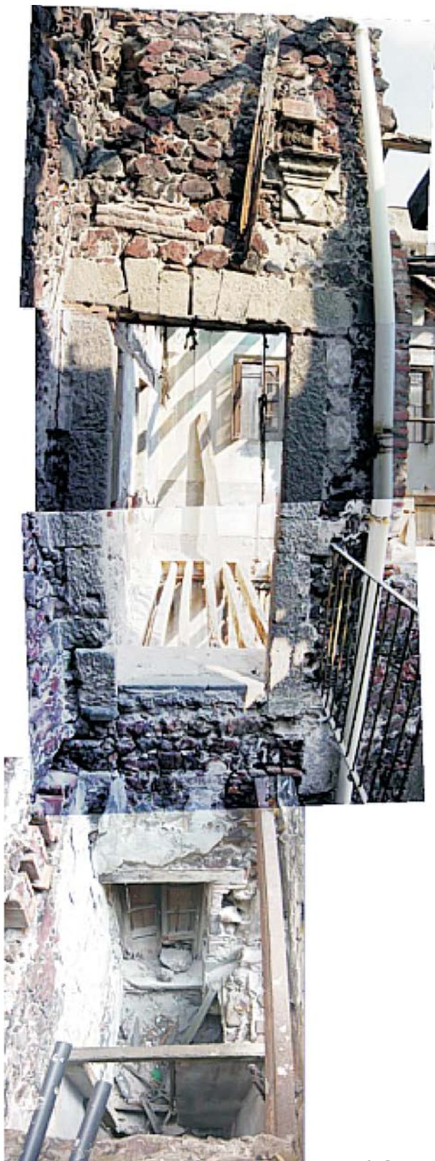
Corredor hacia cuarto 12 vivienda 3 > 19
