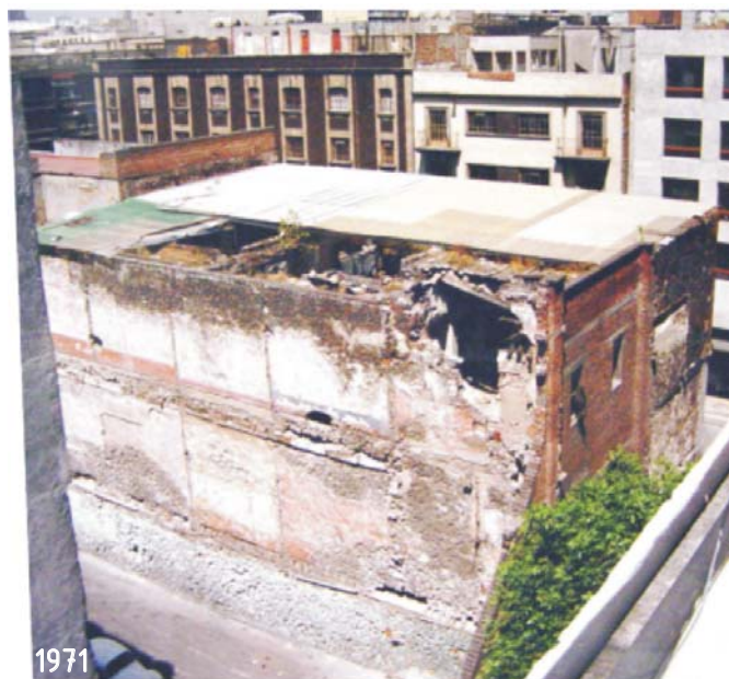
2DA. ETAPA. SUBSTITUCIÓN Y PERDIDA DE CUBIERTAS, AGREGADOS DIVERSOS LATERALES. ③
