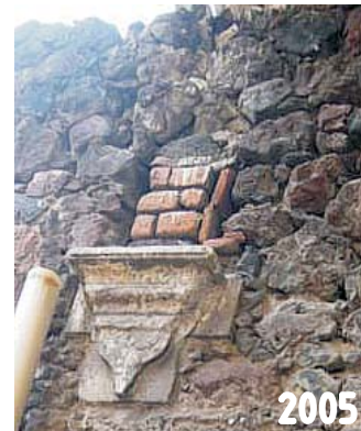
Perdida de aplanado y secciones de muros 16 17
