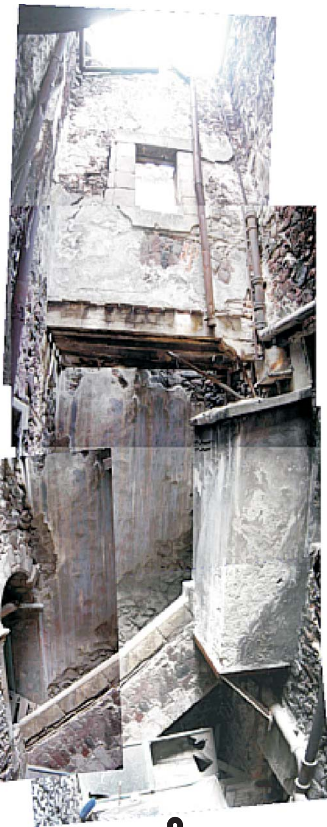
Patio segundo ,escalera secundaria
