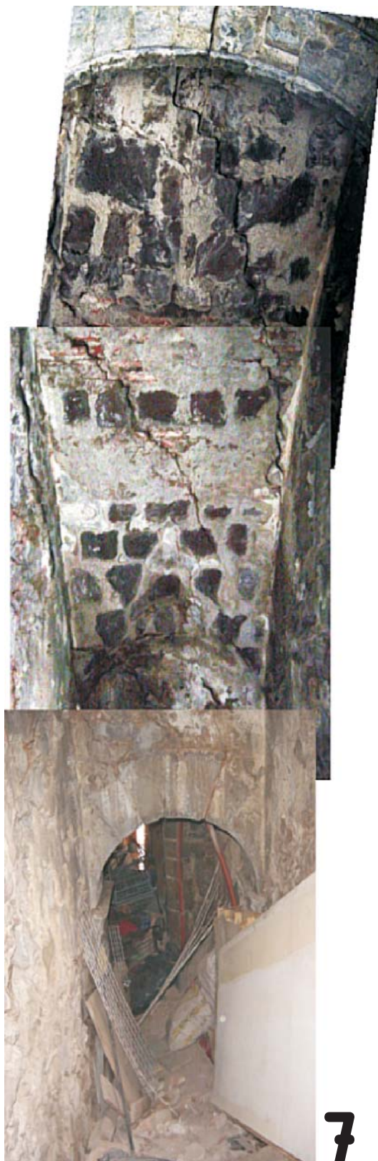
Parte baja abovedada de escalera principal 7
