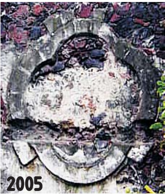
Perdida de aplanado y secciones de muros 16 17
