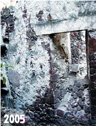
Perdida de aplanado y secciones de muros 16 17
