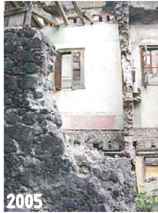
Perdida de aplanado y secciones de muros 16 17
