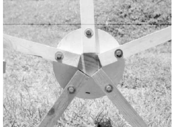
Conector pentagonal con taquete de madera al centro.
