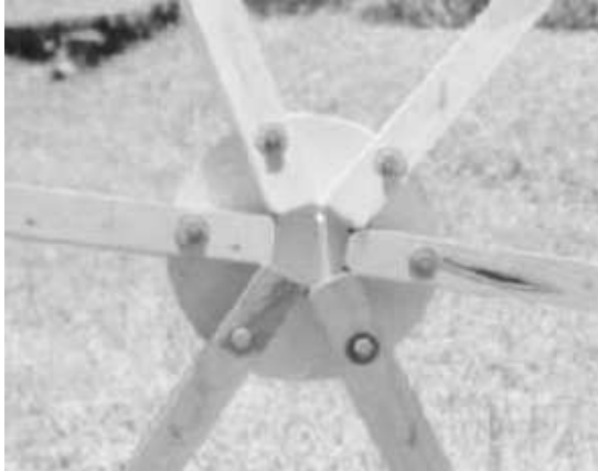
Conector con taquete de madera al centro Para posicionar las barras de madera.
