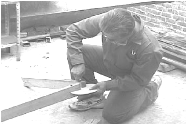
Ensamble de un mòdulo triangular con el conector de disco.
