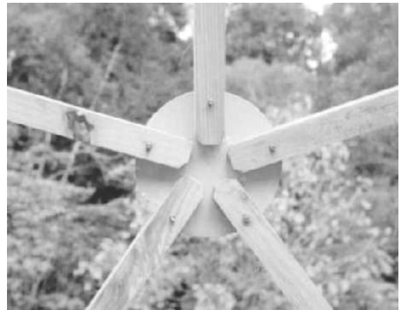
Conector pentagonal con godigo de color, para las barras mas cortas.
