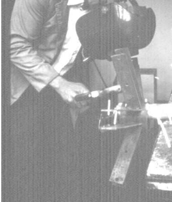
Soldadura del conector
