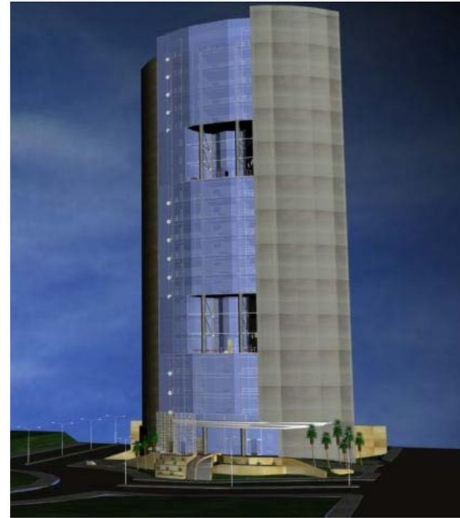
La fachada del edificio cuenta con cristales que poseen una curvatura de protección contra la carga térmica, que aún así dan un aspecto de alta transparencia. El concepto de eficiencia energética se ve enormemente reforzado por el doble acristalamiento de las fachadas que llevan este material, logrando disminuir el consumo de energía en los sistemas de aire acondicionado.
