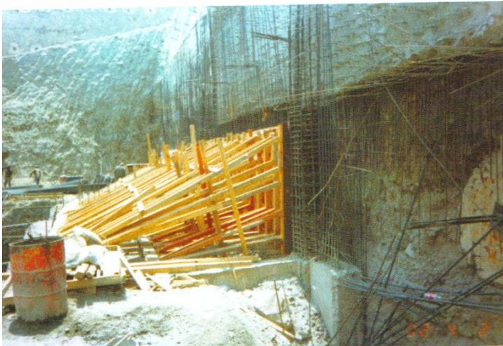
Proceso de construcción de muro perimetral de contención en sótanos adosado a muro de concreto lanzado.
