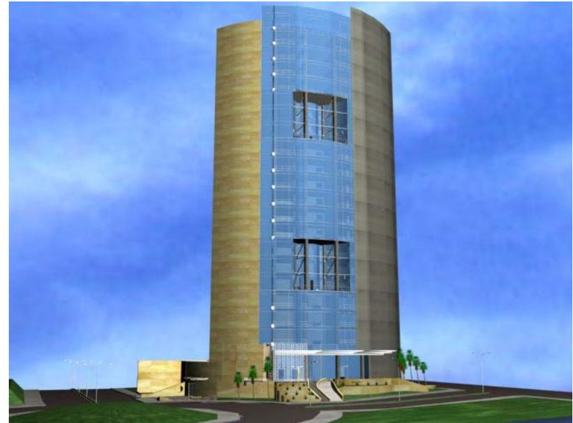
En el proyecto se aprecia una secuencia de tonos y texturas armónicamente combinadas con gusto y elegancia. En las fachadas predominan pantallas de cristal templado transparente y de baja emisividad con secciones de aluminio, paneles metálicos de aluminio esmaltado.
