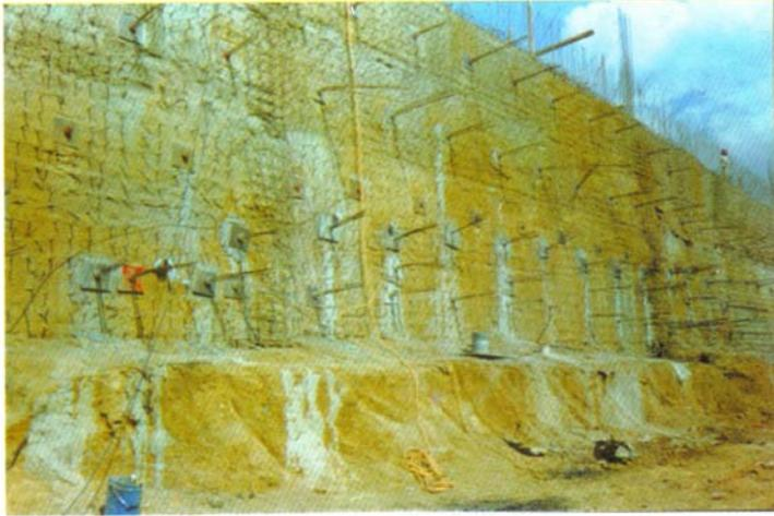
Vista de proceso de excavación para alojar niveles de sótanos por medio de sistema de anclaje y concreto lanzado.
