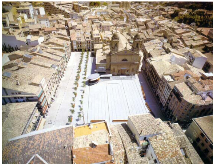
FIGURA 13 VISTA AÉREA DE LA PLAZA FUEROS
