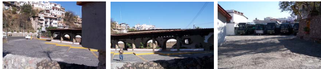
VISTAS DE TERMINAL ESTRELLA DE ORO
