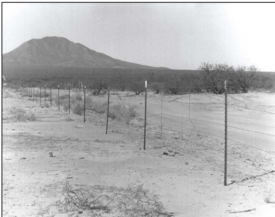
Frontera entre Sonora y Arizona, donde se construye el Muro
