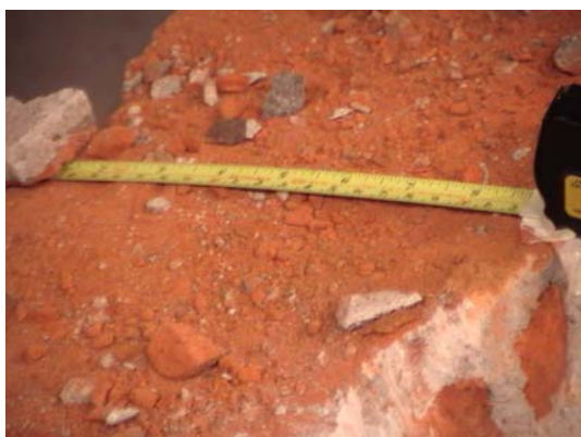
Foto 3.1 Espesor del muro de 25 cm. Imagen tomada al derribar el muro de prueba.
