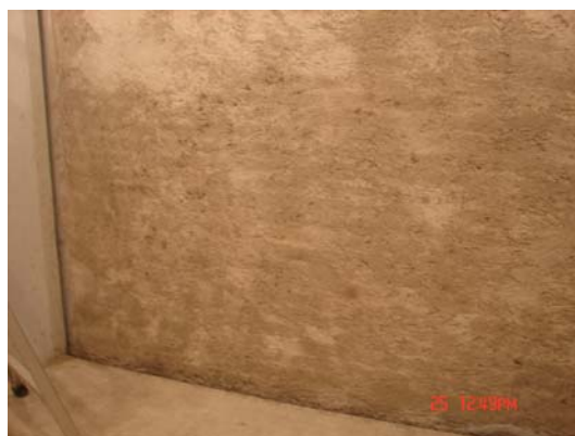
Foto 3.2. Muro construido para la caracterización para generar condiciones de aislamiento máximo
