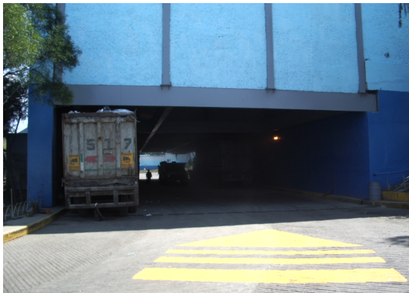
Figura 6.3 Túnel de tractocamiones para recepción de desechos
